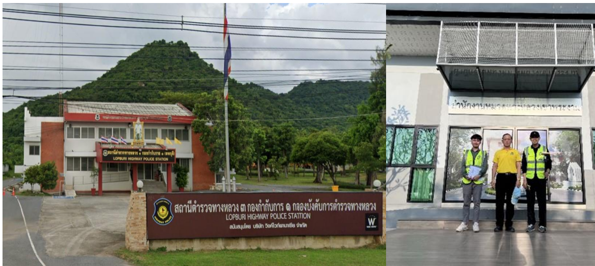
รูปที่ 3-17 สถานีตำรวจทางหลวง 3 กองกำกับการ 1 ใช้พื้นที่ของกรมทางหลวงเขาพระงาม
