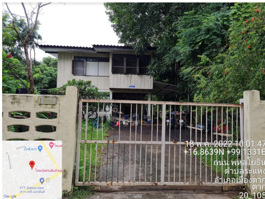
รูปที่ 2-62 อาคารที่เก็บตำแหน่งบริเวณรั้วทางเข้าอาคาร
