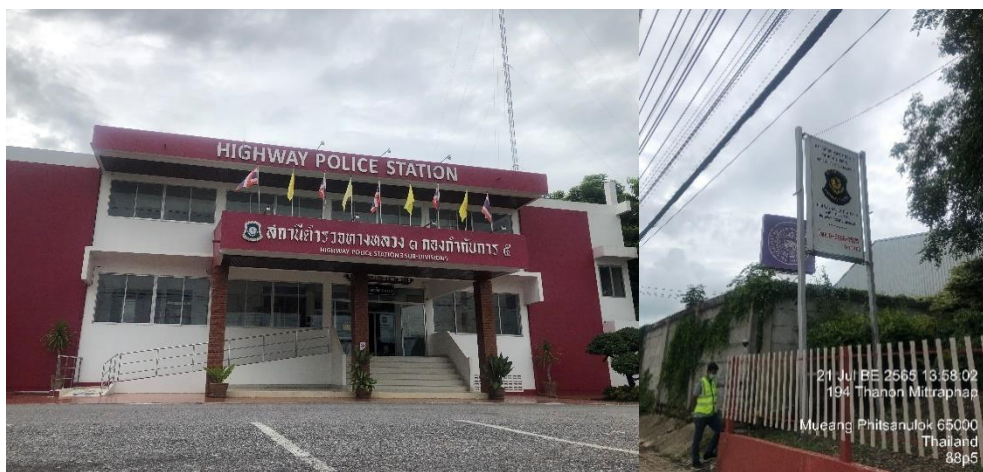
รูปที่ 3-13 สถานีตำรวจทางหลวง 3 กองกำกับการ 5 ใช้พื้นที่ของกรมทางหลวง
