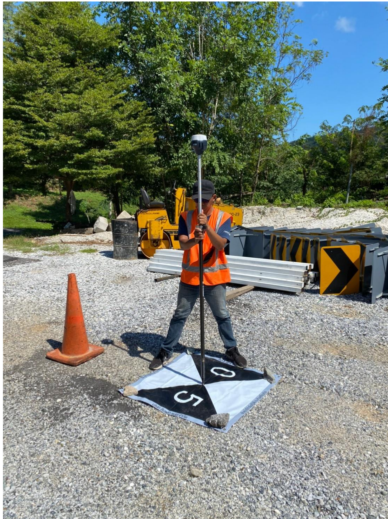
รูปที่ 3-27 การรังวัดค่าพิกัดจุดควบคุมภาพถ่ายด้วยเครื่องรับสัญญาณดาวเทียม GNSS
