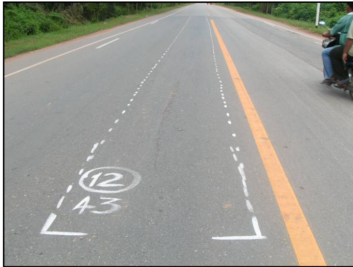
รูปที่ 2.2.1 กำหนดพื้นที่ ที่ทำการฉาบผิว
