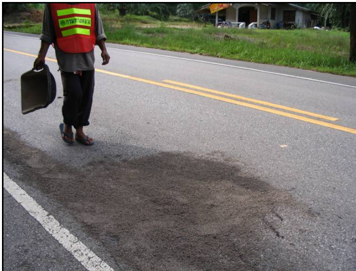
รูปที่ 2.1.3. สาดทรายปิดทับรอยแตกที่อุดด้วยด้วยแอสฟัลต์แล้ว
