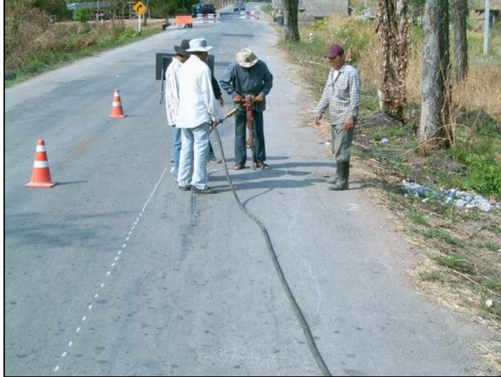
รูปที่ 2.6.1 ขุดตามพื้นที่ที่จะทำการซ่อม
