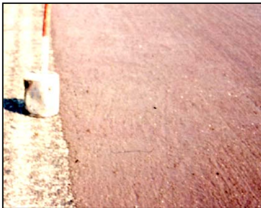
รูปที่ 2.4.5 ผิวทางแบบ Slurry Seal ที่บ่มและแห้งแล้ว
