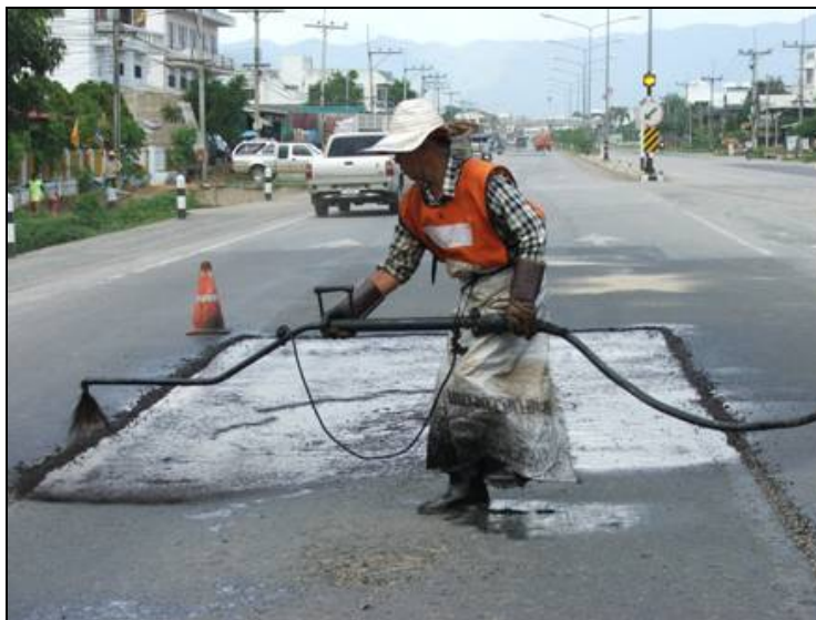
รูปที่ 2.7.1 Tack Coat บนผิวทางเดิมที่ได้กำหนดขอบเขตพื้นที่และทำความสะอาดแล้ว
