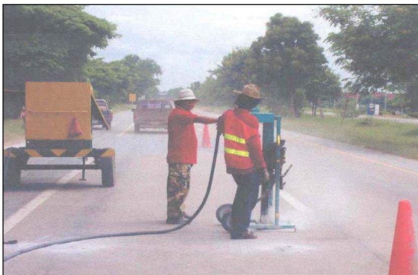
รูปที่ 3.6.5 เจาะรูแผ่นพื้นคอนกรีต
