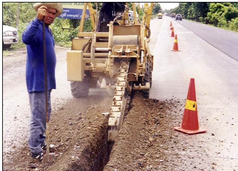
รูปที่ 4 ขุดร่องตามแนวที่กำหนด
