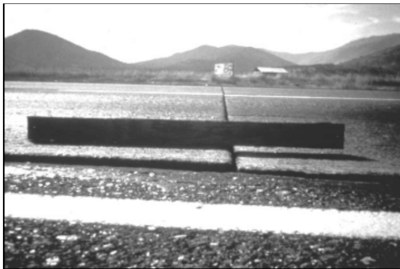
รูปที่ 3.3.1 การชุดแต่งผิวหน้าคอนกรีตสามารถใช้ปรับปรุงผิวหน้าบริเวณรอยต่อที่ไม่เรียบ
