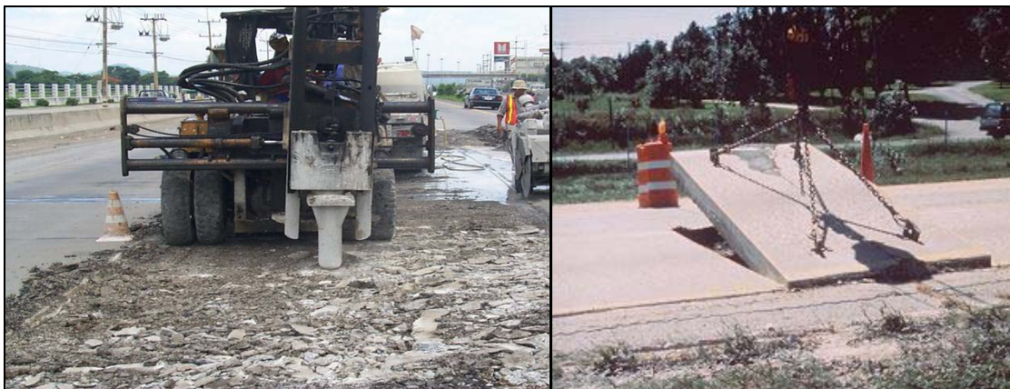
รูปที่ 3.7.3 นำแผ่นพื้นคอนกรีตออกโดยวิธีทุบให้แตกหรือวิธียกออก
