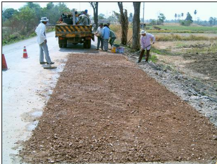
รูปที่ 2.6.4 นำวัสดุชั้นทางที่เหมาะสมมาก่อสร้างตามข้อกำหนด
