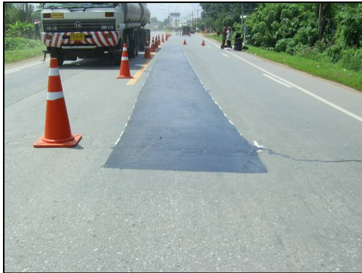
รูปที่ 2.2.3 ผิวทางเมื่อทำการฉาบผิวทางแบบฟ็อกซีลเสร็จ รอเปิดจราจร
