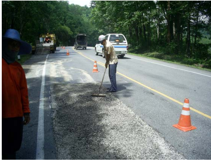
รูปที่ 2.3.5 เกลี่ยหินย่อยให้กระจายอย่างสม่ำเสมอ
