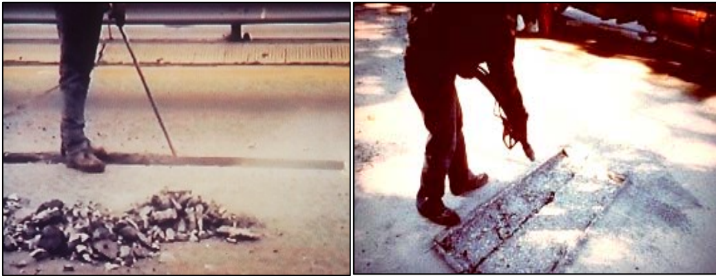
รูปที่ 3.5.3 ทำความสะอาดด้วยเครื่องพ่นทราย (Sand Blast) และเครื่องเป่าลม
