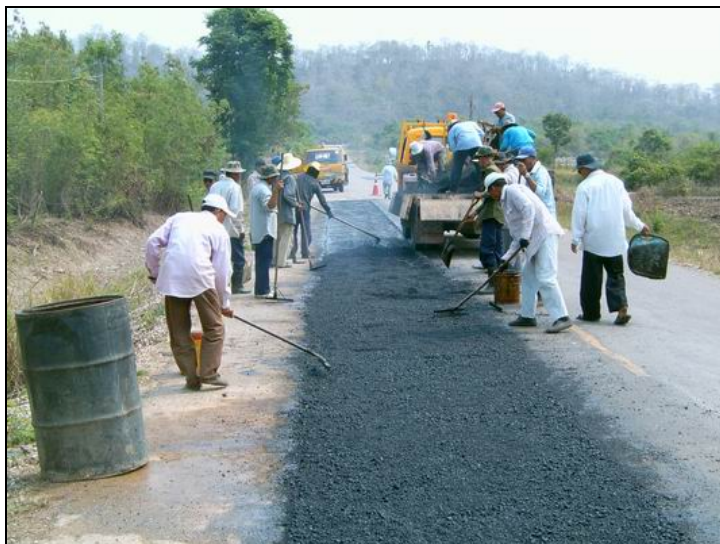
รูปที่ 2.6.6 ปูวัสดุ Premix พร้อมเกลี่ยแต่งปรับระดับให้เรียบ
