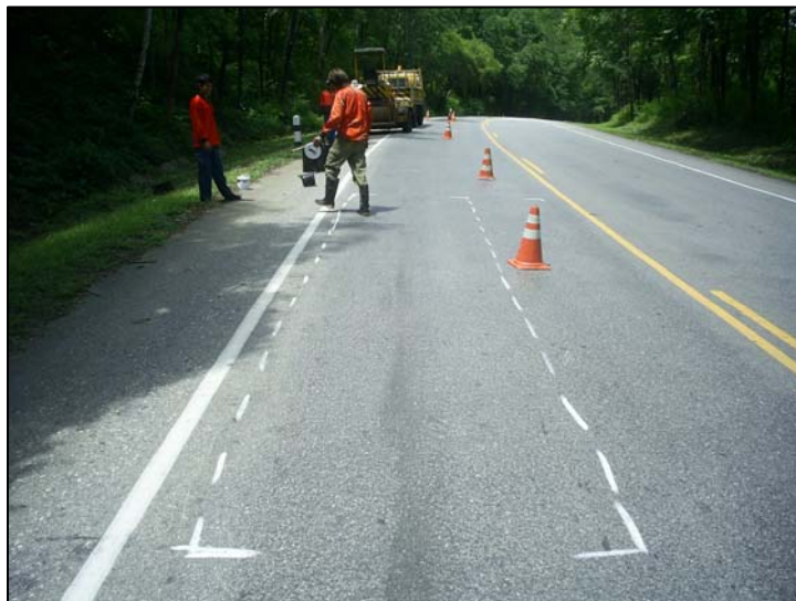
รูปที่ 2.3.1 กำหนดพื้นที่ ที่ทำการฉาบผิว
