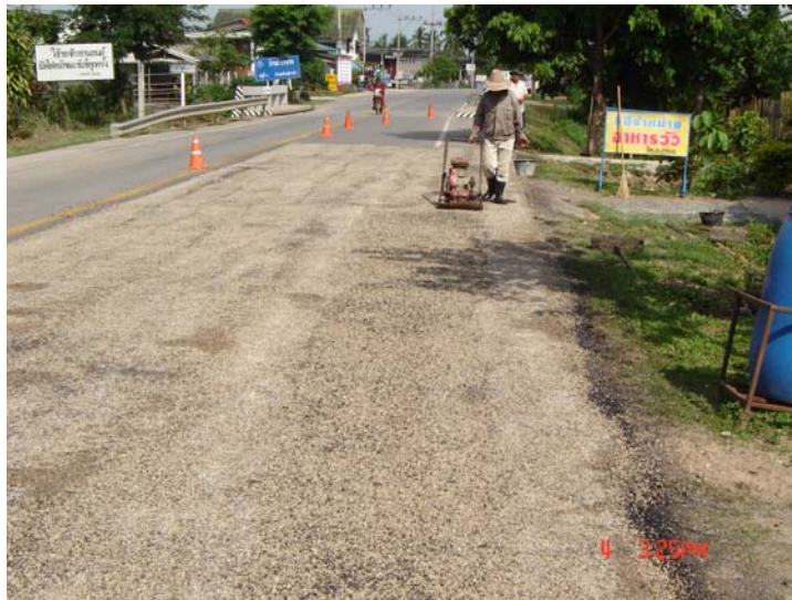
รูปที่ 2.3.6 การเลือกเครื่องมือที่ไม่เหมาะสม จะทำให้แอสฟัลต์เซ็ทตัวก่อนที่จะทำการบดทับแล้วเสร็จ
