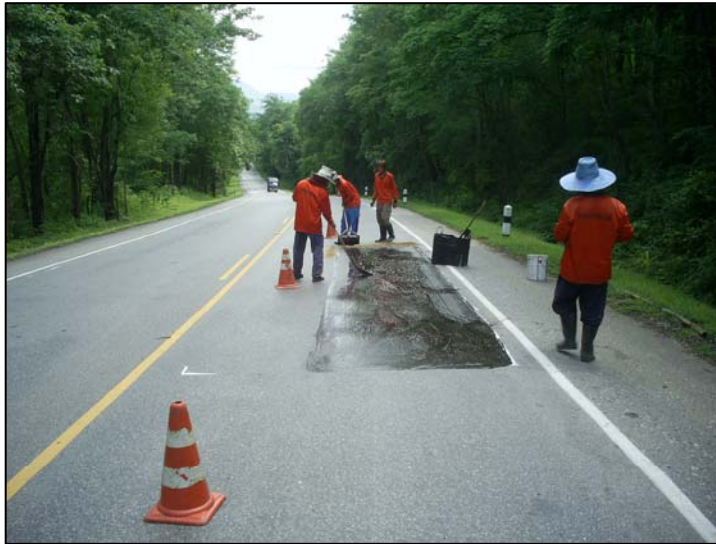
รูปที่ 2.3.2 ราดแอสฟัลต์ที่เตรียมไว้
