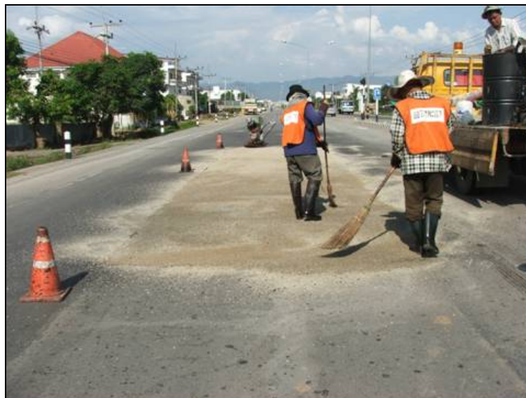
รูปที่ 2.7.4 สาดหินฝุ่นปิดทับก่อนเปิดการจราจร
