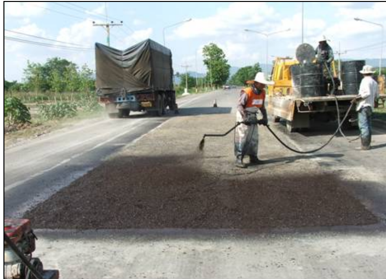
รูปที่ 2.7.3 กรณีปูด้วย Cold Mix อากาศแอสฟัลต์เพื่ออุดช่องว่าง
