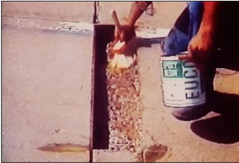
รูปที่ 3.5.5 ทาน้ำยาประสานคอนกรีต
