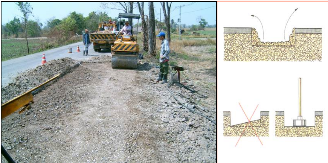
รูปที่ 2.6.3 บดทับกันหลุมให้มีความเรียบ
