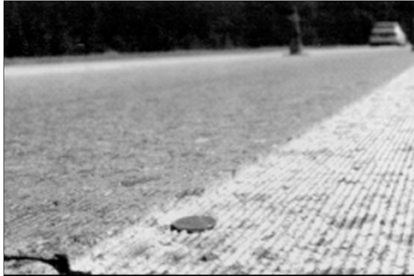
รูปที่ 3.3.4 ลักษณะของผิวหลังจากทำ Grinding แล้ว
