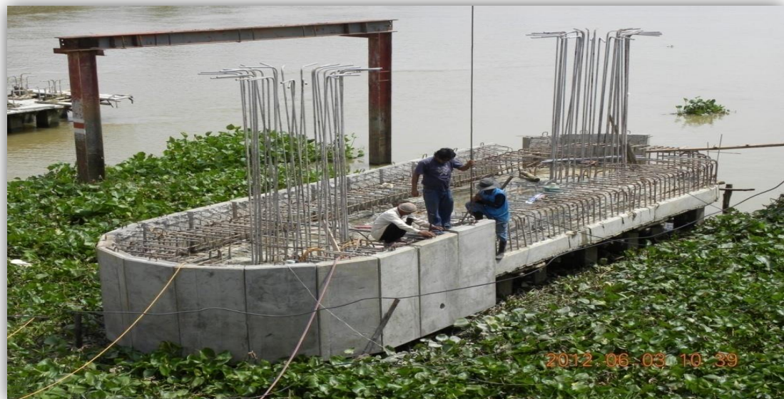
ภาพการก่อสร้างตอม่อในแม่น้ำขนาดเล็ก
