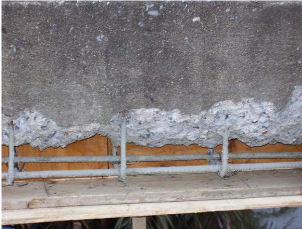
รูปที่ 7.19 ประกอบไม้แบบ
