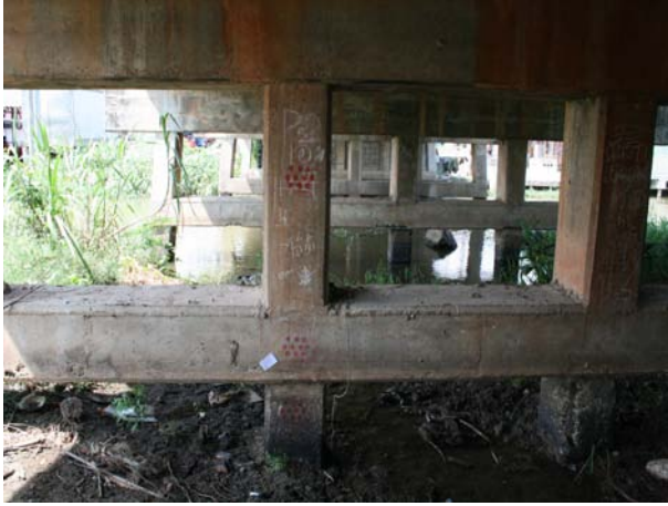
รูปที่ 2.14 ทดสอบกำลังรับแรงอัดของคอนกรีตด้วย Rebound hammer
