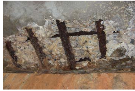
รูปที่ 3.8 แสดงการเกิดสนิมในเหล็กเสริม
