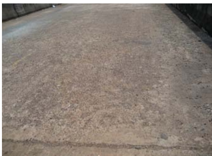
รูปที่ 3.3 แสดงการสูญเสียปูนฉาบที่ผิวหน้าและมวลรวมคอนกรีตเนื่องจากการหลุดลอก
