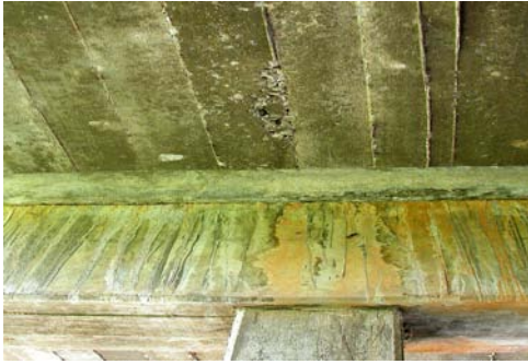
รูปที่ 3.6 แสดงการเกิดคราบเกลือบนเนื้อคอนกรีต
