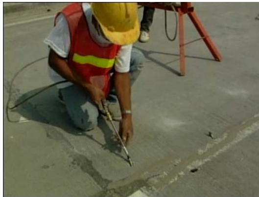
รูปที่ 7.25 อัดฉีดอีพ็อกซี่ด้วยแรงอัด
