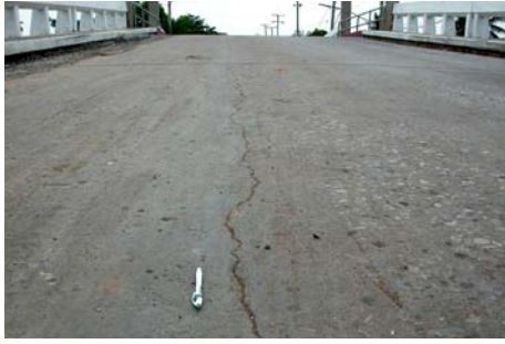
รูปที่ 3.1 แสดงพื้นผิวสะพาน และตอม่อที่แตกร้าวเสียหาย
