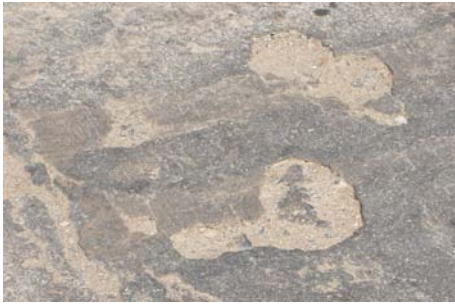
รูปที่ 3.4 แสดงความเสียหายที่เกิดจากการหลุดออกเป็นแผ่น
