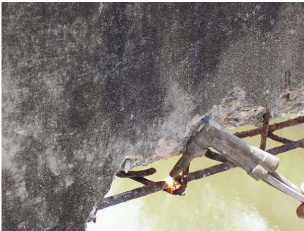
รูปที่ 7.18 แสดงการเสริมเหล็กในส่วนที่สกัดรี้ออก
