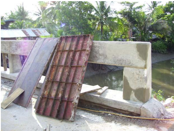
รูปที่ 7.20 เทคอนกรีตใหม่ทั้งหน้า
