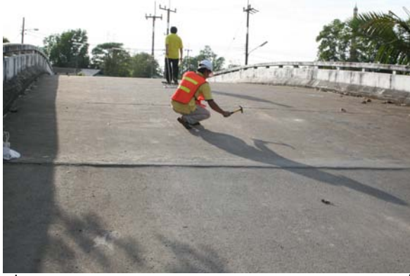
รูปที่ 2.11 การใช้ค้อนเคาะเพื่อตรวจสอบการหลุดลอกเป็นแผ่นและโพรงของพื้นสะพาน
