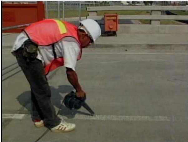
รูปที่ 7.21 เป่าทำความสะอาดพื้นสะพาน
