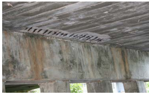
รูปที่ 3.2 แสดงรอยชำรุดเนื่องจากเกิดการหลุดกะเทาะ
