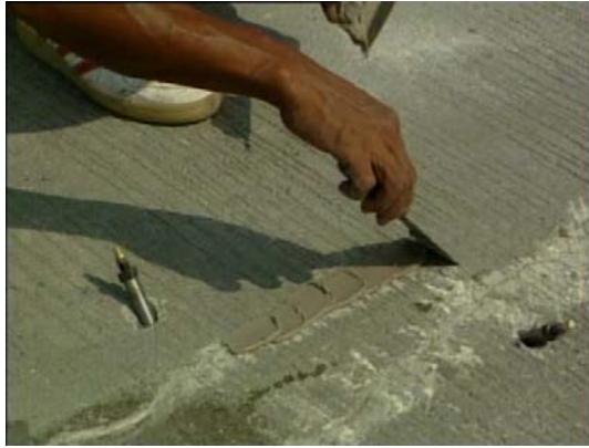
รูปที่ 7.24 อุดรอยแตกร้าวที่ทำการเซาะร่อง
