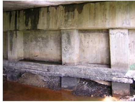
รูปที่ 3.6 แสดงการเกิดคราบเกลือบนเนื้อคอนกรีต
