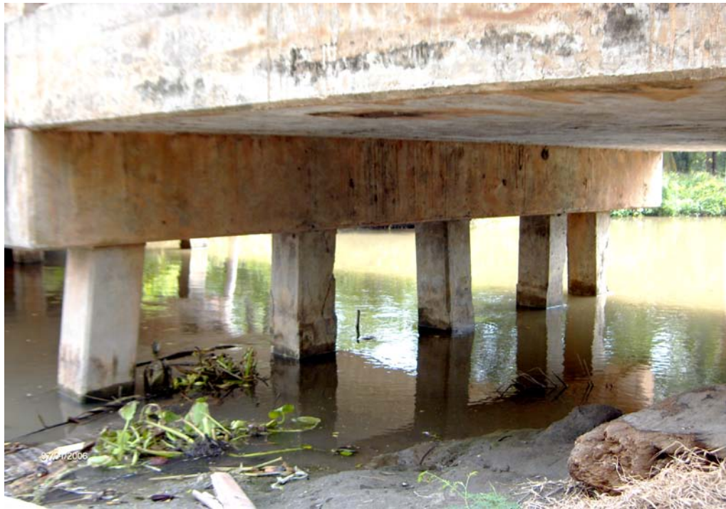
รูปที่ 2.19 แสดงภาพความเสียหายของเสาตอม่อ P1/1-P1/5
