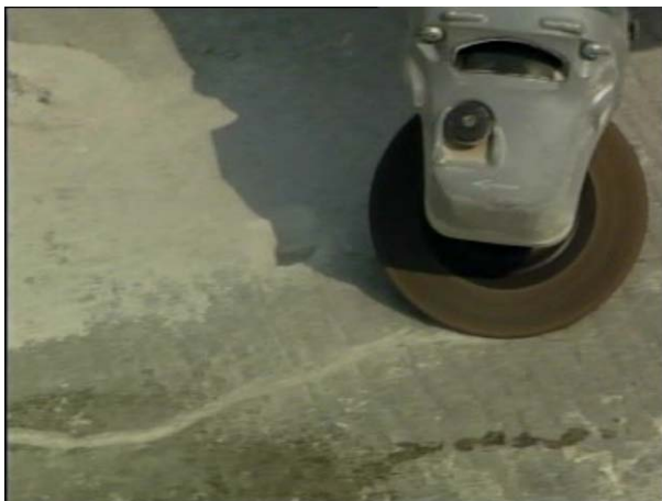
รูปที่ 7.22 เซาะร่องพื้นคอนกรีตเป็นรูปตัววี
