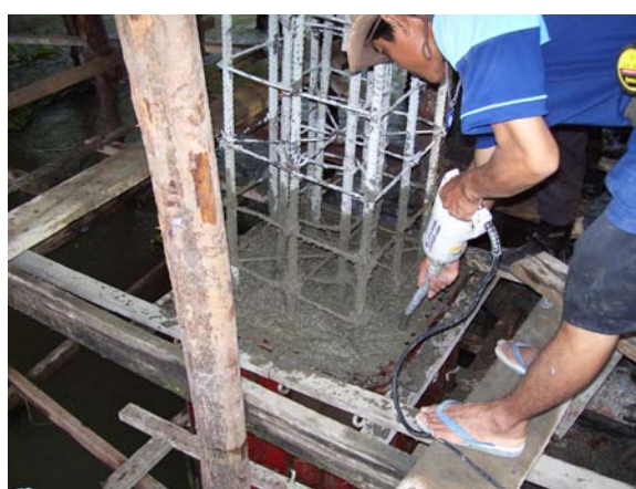
รูปที่ 9.12 การเทคอนกรีตเสาตอม่อ
