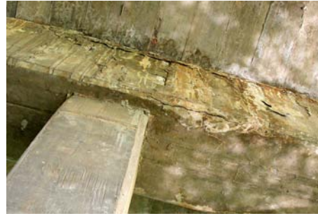
รูปที่ 3.4 แสดงความเสียหายที่เกิดจากการหลุดออกเป็นแผ่น
