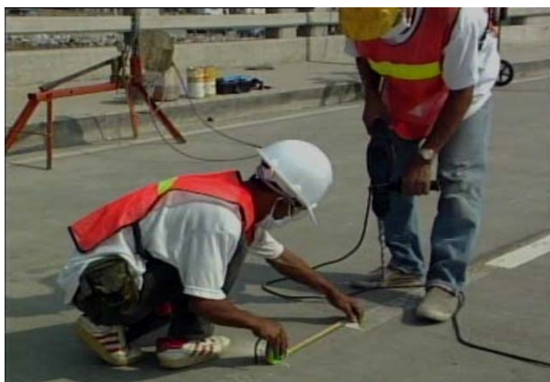
รูปที่ 7.23 กำหนดระยะที่ทำการซ่อมพร้อมเจาะรูสำหรับติดตั้งหัวฉีดยา
