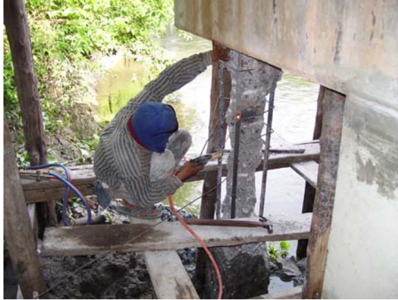
รูปที่ 9.8 ข แสดงการต่อเชื่อมเพื่อเสริมเหล็กใหม่
