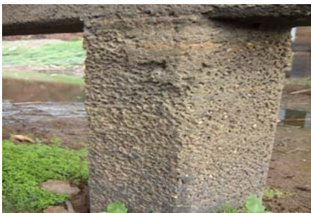
รูปที่ 3.7 แสดงการเกิดการสึกกร่อนต่อผิวของชิ้นส่วน
