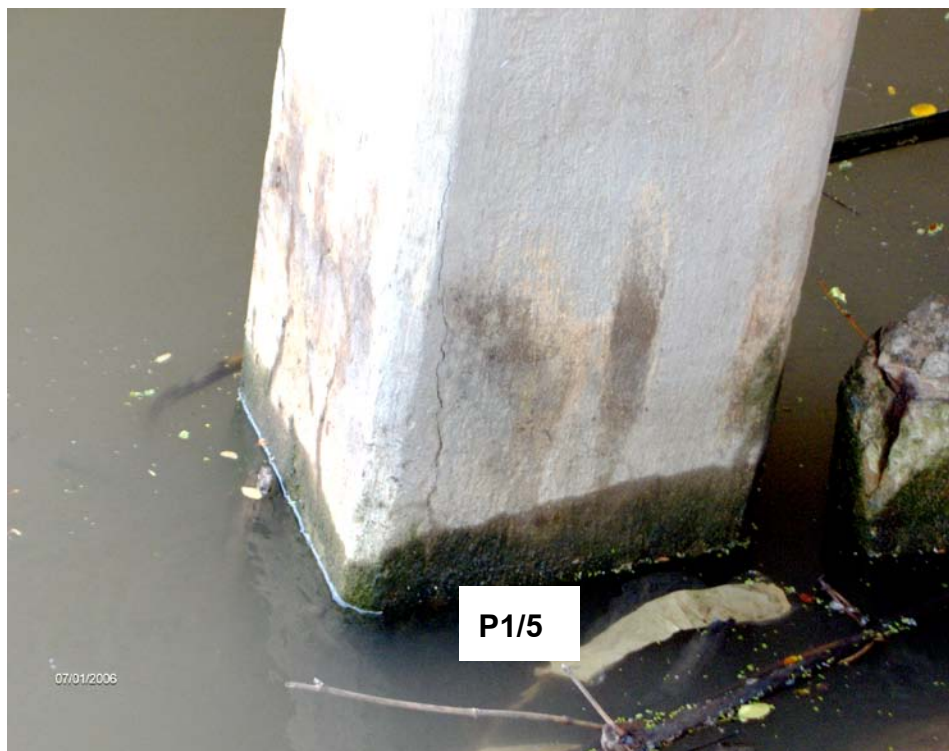
รูปที่ 2.23 ภาพแสดงความเสียหายของเสาตอม่อ P1/5
