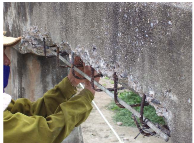
รูปที่ 7.18 แสดงการเสริมเหล็กในส่วนที่สกัดรี้ออก
