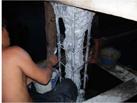
รูปที่ 9.10 แสดงการทาวัดเพิ่มแรงยึดเหนี่ยว
