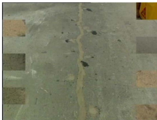
รูปที่ 7.25 อัดฉีดอีพ็อกซี่ด้วยแรงอัด
