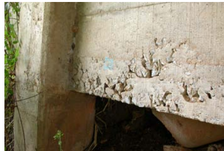
รูปที่ 3.5 แสดงการเกิดรูพรุนและช่องว่างบนเนื้อคอนกรีต
