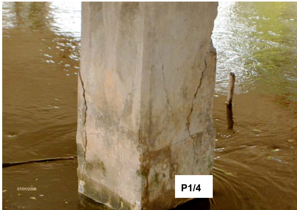
รูปที่ 2.22 ภาพแสดงความเสียหายของเสาตอม่อ P1/4
