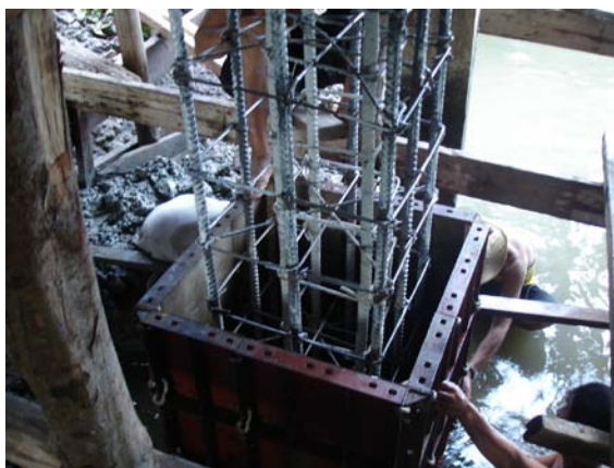
รูปที่ 9.11 แสดงแบบหล่อเสาตอม่อ
