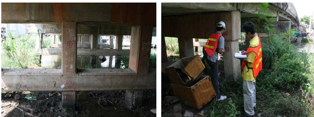
รูปที่ 2.14 ทดสอบกำลังรับแรงอัดของคอนกรีตด้วย Rebound hammer
