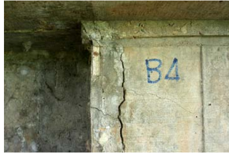
รูปที่ 3.1 แสดงพื้นผิวสะพาน และตอม่อที่แตกร้าวเสียหาย
