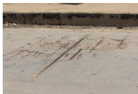
รูปที่ 3.3 แสดงการสูญเสียปูนฉาบที่ผิวหน้าและมวลรวมคอนกรีตเนื่องจากการหลุดลอก
