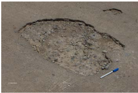
รูปที่ 3.2 แสดงรอยชำรุดเนื่องจากเกิดการหลุดกะเทาะ
