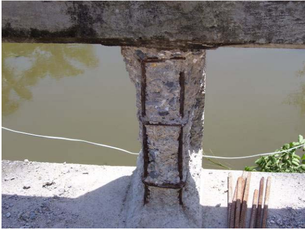
รูปที่ 7.17 แสดงผิวคอนกรีตสกัดคอนกรีตที่ชำรุด
