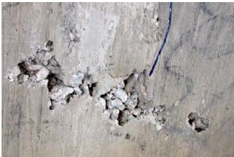
รูปที่ 3.5 แสดงการเกิดรูพรุนและช่องว่างบนเนื้อคอนกรีต
