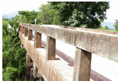
รูปที่ 3.7 แสดงการเกิดการสึกกร่อนต่อผิวของชิ้นส่วน
