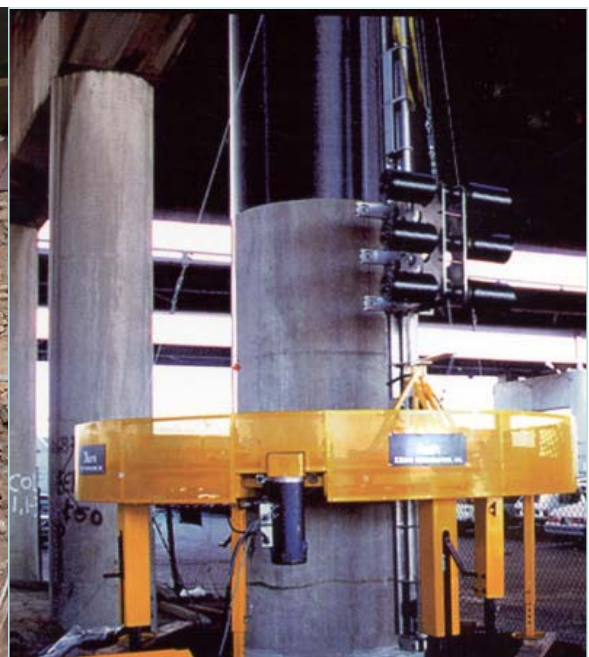
ค (การพัน Carbon fiber sheet โดยใช้เครื่องจักร
