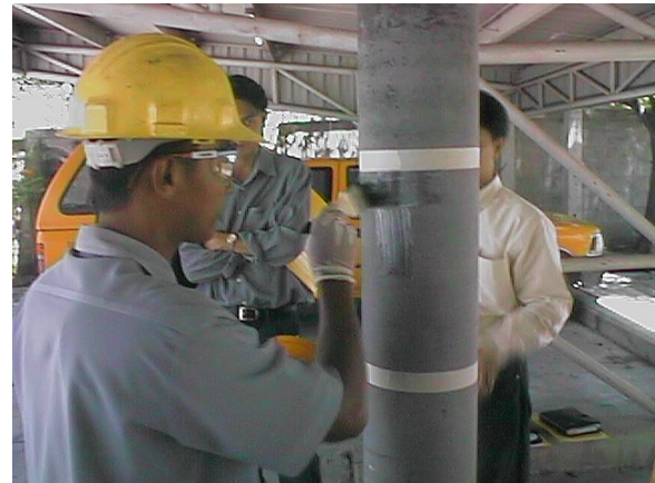
ข. การทา Primer ลงบนพื้นผิวงาน
