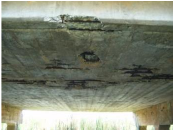
รูปที่ 4-9 การสึกกร่อนใต้พื้นสะพาน
