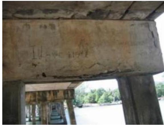
รูปที่ 4-28 สภาพการแตกร้าวของคานรัดหัวเสา
