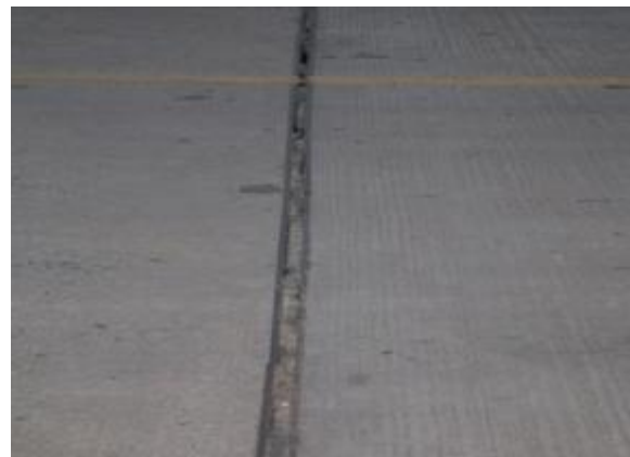
รูปที่ 4-74 สภาพรอยต่อเพื่อการขยายตัวของสะพาน
