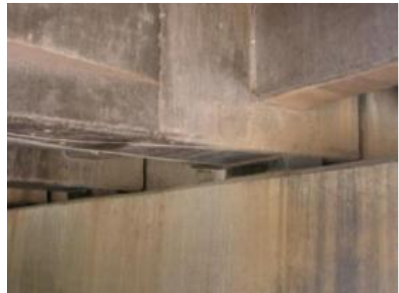
รูปที่ 4-69 รูปแสดงลักษณะแผ่นรองรับคาน
