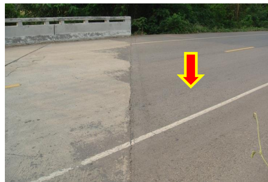
รูปที่ 2-23 เชิงลาดสะพาน
