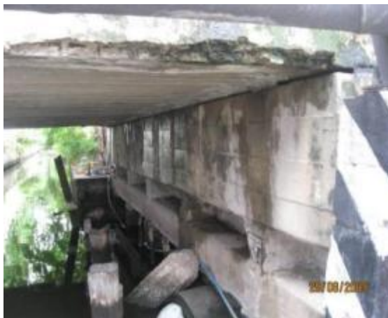
รูปที่ 4-44 ความเสียหายบริเวณเสาตอม่อสะพานที่คอนกรีตกะเทาะออกจนสามารถเห็นเหล็กเสริมได้
