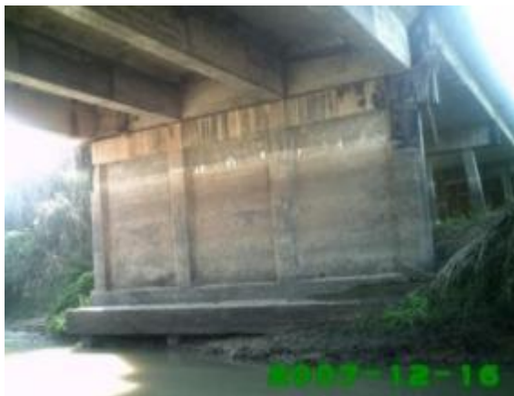
รูปที่ 4-52 เกิดการกัดเซาะของดินบริเวณฐานราก
