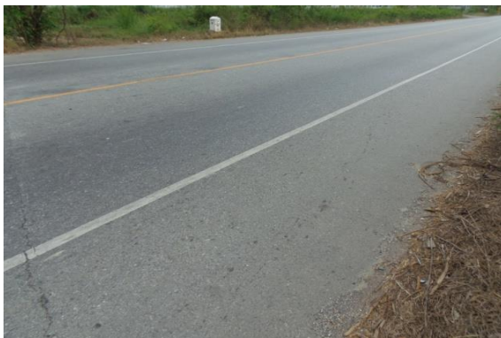
รูปที่ 5-12 ผิวทางเชิงลาด (4-สภาพดีพอใช้)
