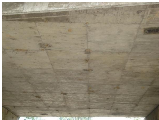
รูปที่ 2-1 สะพานคอนกรีตเสริมเหล็กแบบหล่อในที่ (RC Slab Type)
