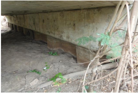
รูปที่ 5-28 คานรัดหัวเสา (4-สภาพดีพอใช้)
