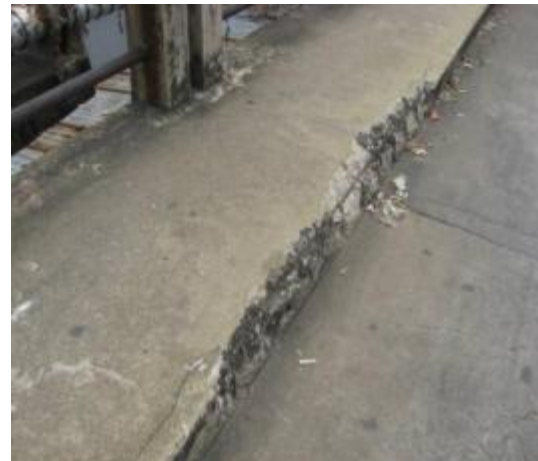
รูปที่ 4-88 เสียหายจากการชน
