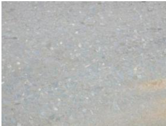
รูปที่ 4-76 ลักษณะการสึกกร่อนของผิวถนนจนเห็นเม็ดหินเกิดขึ้นทั่วสะพาน
