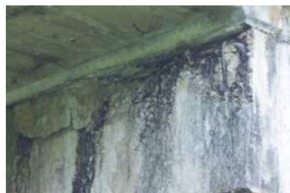
รูปที่ 4-30 มีรูพรุนเหมือนรังผึ้ง
