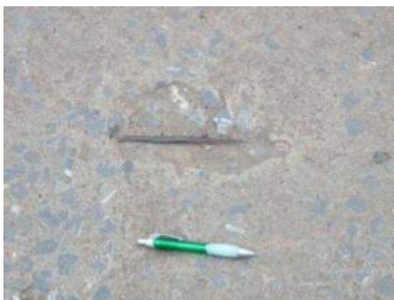
รูปที่ 4-78 ลักษณะการสึกกร่อนของผิวถนนจนเป็นหลุมสามารถเห็นเหล็กเสริมได้
