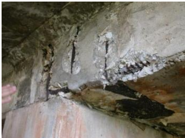
รูปที่ 4-4 การหลุดล่อนได้ผ่านพื้นสะพาน
