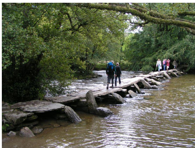
รูปที่ 1-3 สะพานหินแบบ Clapper
