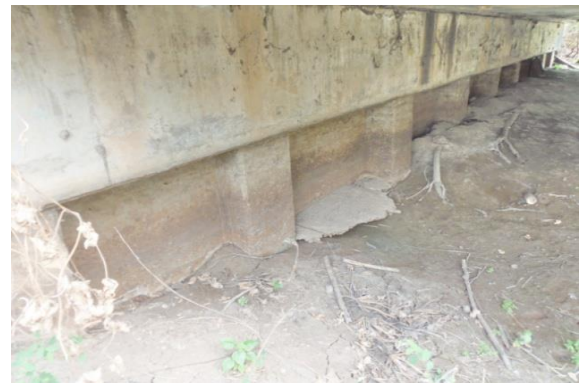
รูปที่ 5-27 กำแพงกันดิน (3-สภาพพอใช้)
