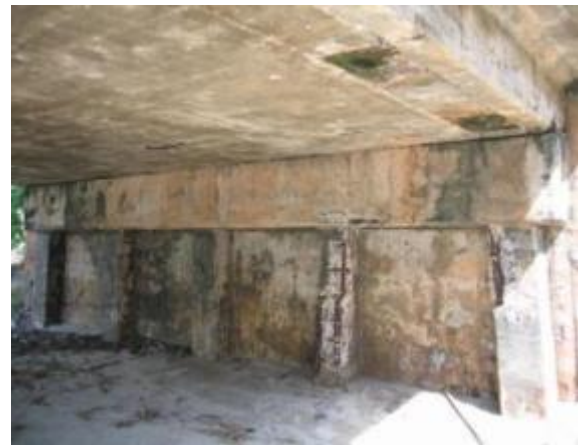
รูปที่ 4-94 สภาพความเสียหายของกำแพงกันดินมีการหลุดล่อนจนเห็นเหล็กเสริม
