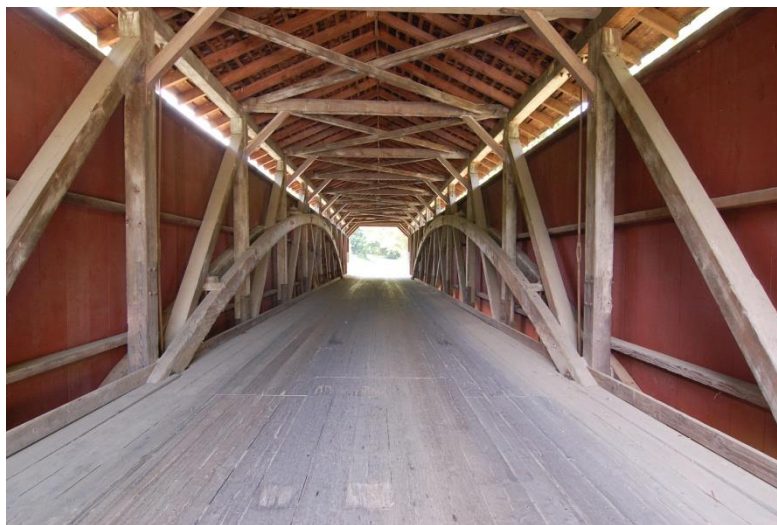
รูปที่ 1-10 โครงถักแบบ Burr Arch
