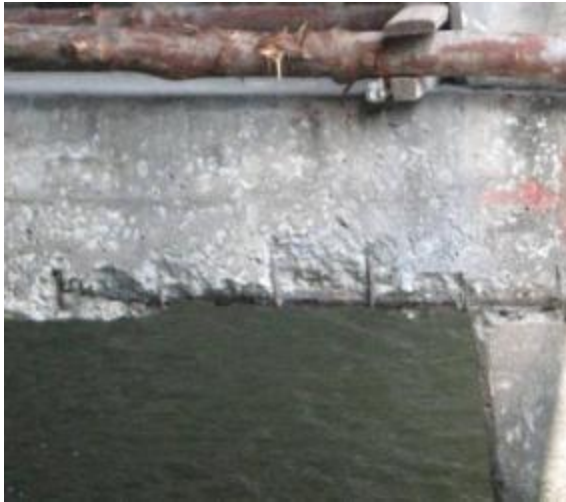
รูปที่ 4-32 มีการสึกกร่อนจนเห็นเหล็กเสริม
