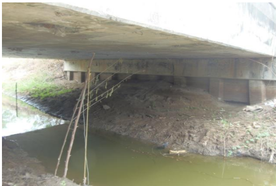
รูปที่ 5-26 คานรัดหัวเสา (4-สภาพดีพอใช้)
