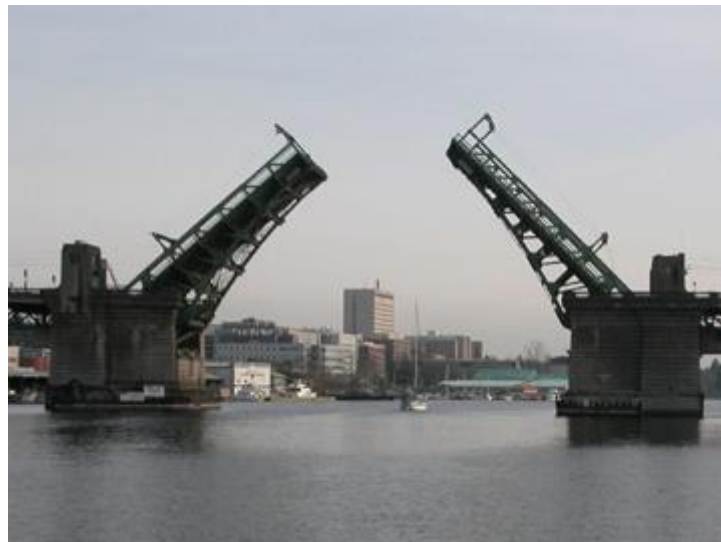
รูปที่ 1-12 สะพานแบบ Bascule
