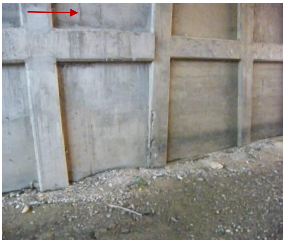
รูปที่ 4-49 แตกร้าวตามแนวเหล็กเสริม
