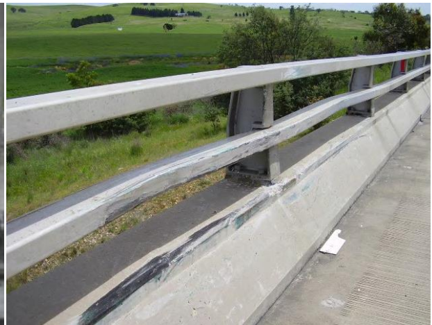
รูปที่ 4-84 เสียหายจากการชน
