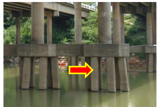
รูปที่ 2-21 เสาเข็ม
