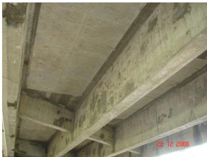
รูปที่ 2-6 สะพานแบบคานคอนกรีตเสริมเหล็กรูปตัวทีหล่อในที่ (RC T-Girder)
