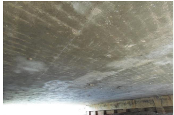
รูปที่ 5-31 แผ่นพื้น (4-สภาพดีพอใช้)
