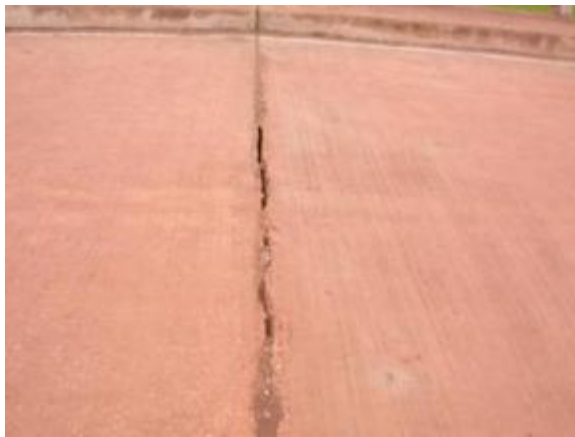
รูปที่ 4-71 รอยต่อเพื่อการขยายตัวมีเศษดินอุดตันทำให้พฤติกรรมไม่เป็นไปตามที่ได้ออกแบบ
