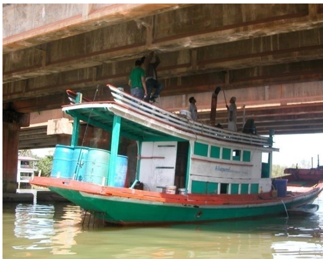
รูปที่ 3-13 แสดงการตรวจสอบโครงสร้างสะพานโดยการใช้เรือ
