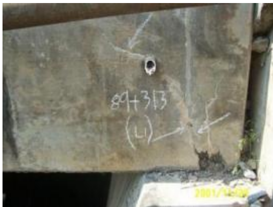
รูปที่ 4-20 รอยแตกจากแรงเฉือนใกล้แผ่นรองรับคาน
