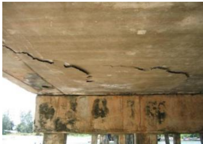
รูปที่ 4-3 การหลุดแยกออกเป็นแผ่นๆ ได้แผ่นพื้นสะพาน
