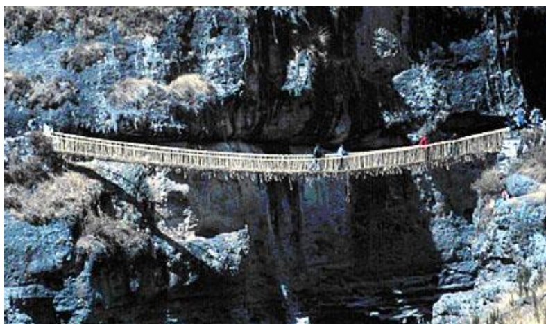
รูปที่ 1-4 สะพานที่ทำมาจากเชือก
