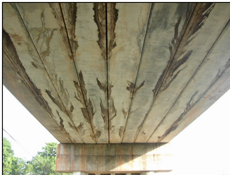
รูปที่ 3-11 Efflorescence
