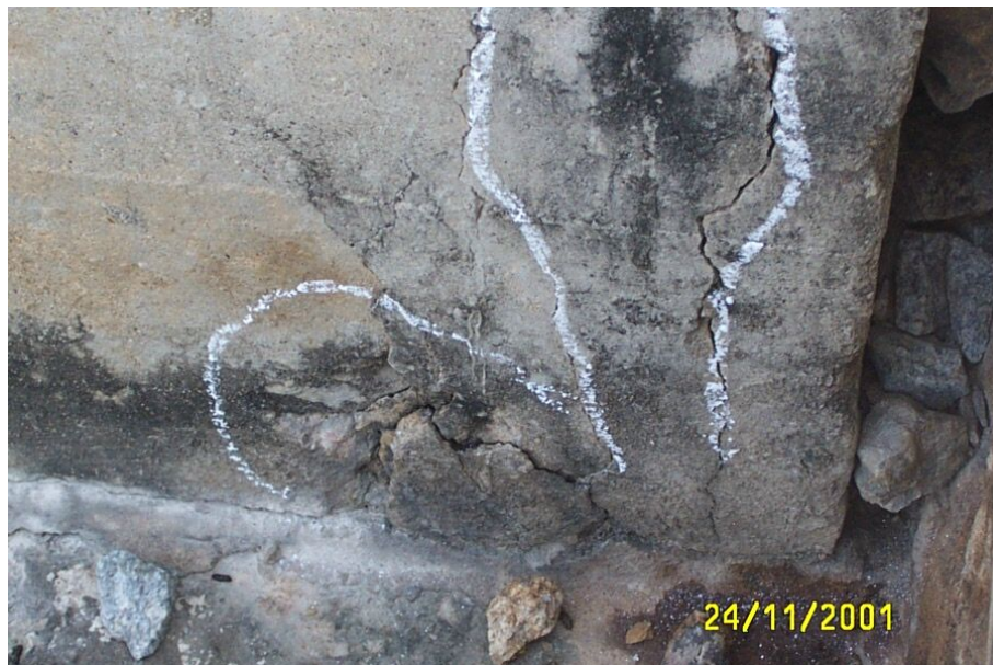
รูปที่ 3-7 Cracks
