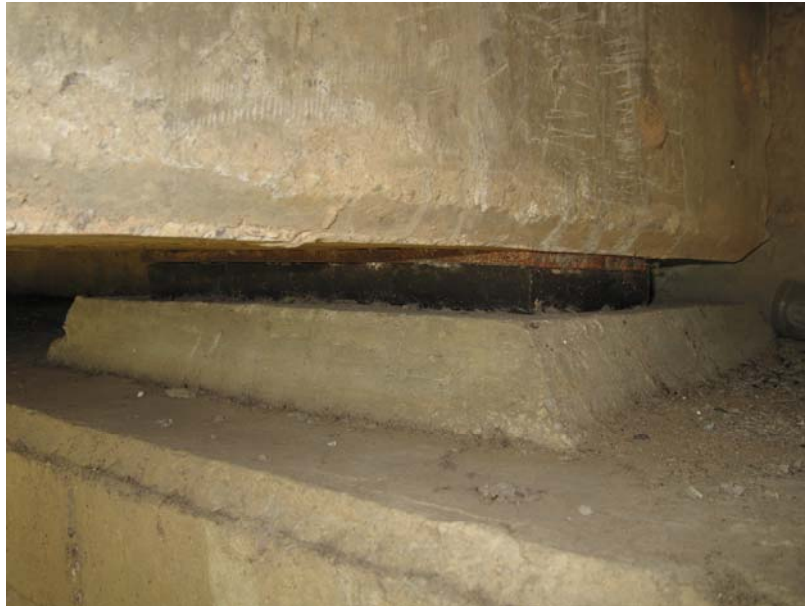
รูปที่ 6-20 Neoprene Bearing
