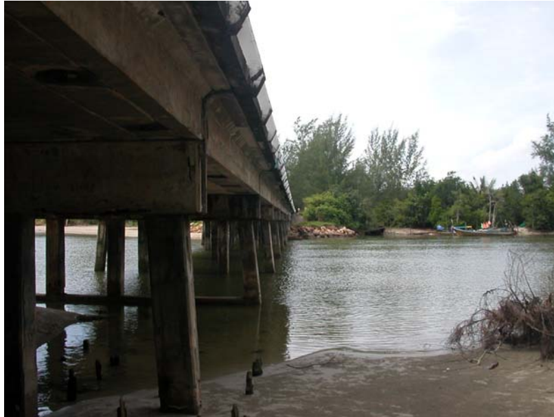
รูปที่ 2-33 การถูกกัดเซาะของตอม่อ
