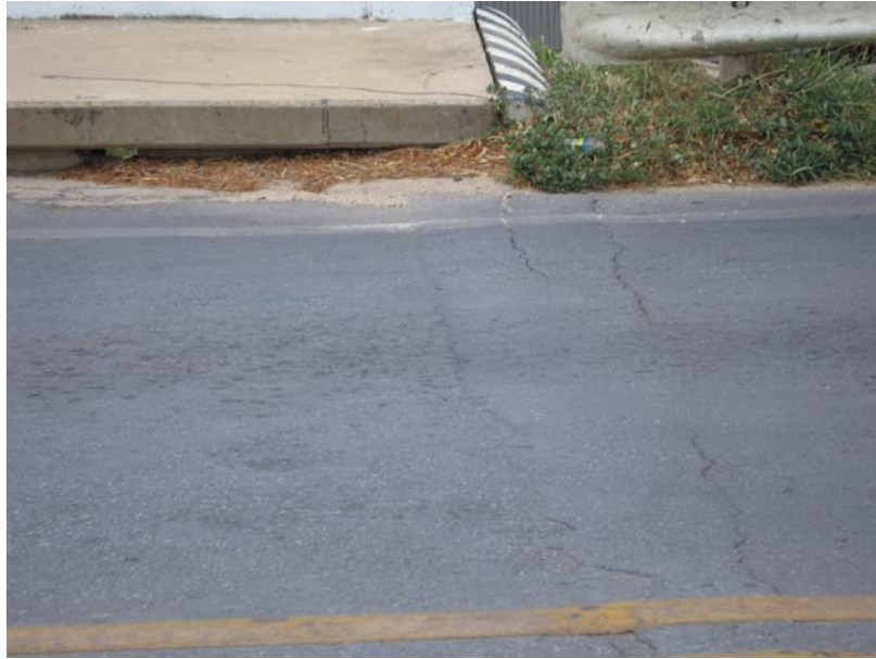
รูปที่ 6-9 Heaving of the Approach Pavement
