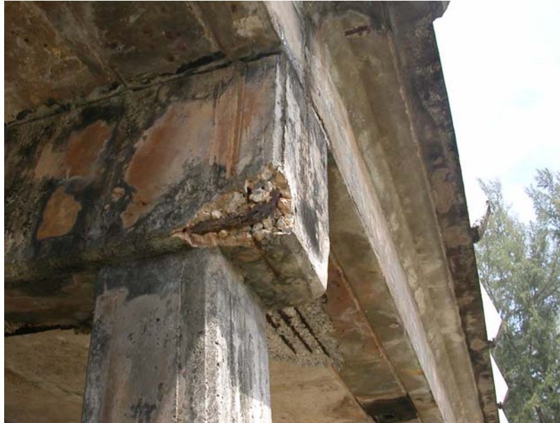
รูปที่ 2-32 การกัดเซาะที่ฐานของ Pier และ Abutment
