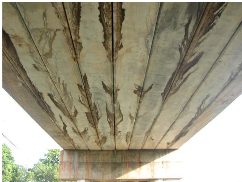
รูปที่ 6-17 Leaking Joints ที่ระหว่าง Boxesที่อยู่ติดกัน
