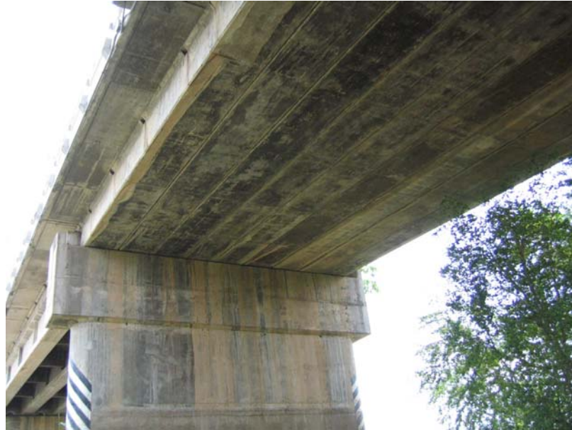
รูปที่ 6-13 รูปแบบทั่วไปของสะพานแบบ Prestressed Slab Beam
