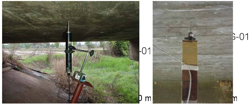
รูปที่ 8-11 ตัวอย่างการติดตั้งอุปกรณ์ตรวจวัดค่าการแอ่นตัว
