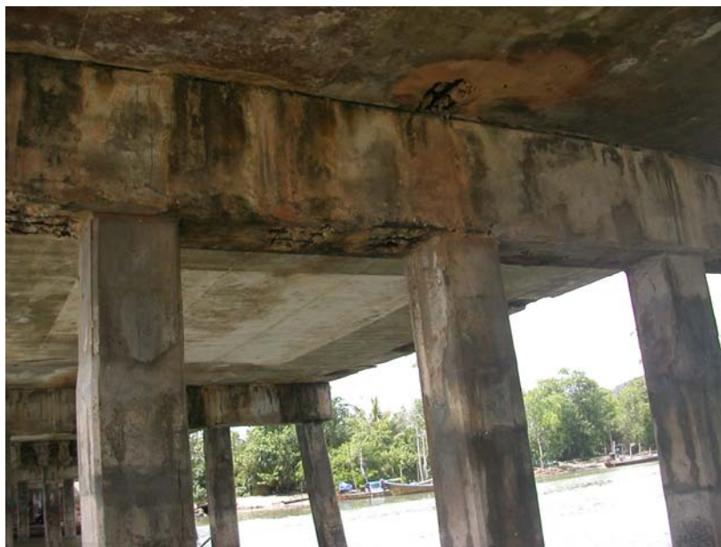
รูปที่ 2-25 Support ที่ด้านใต้พื้นสะพาน
