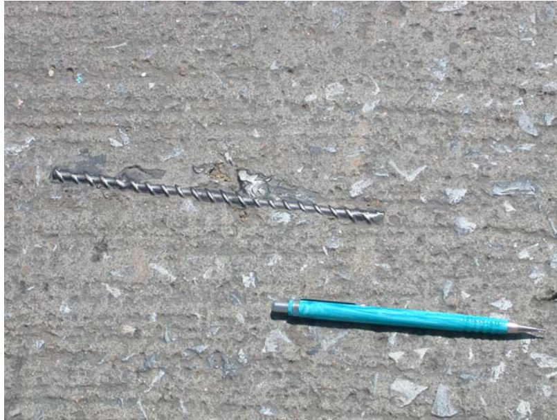
รูปที่ 6-1 การขำรดของพื้นสะพานคอนกรีต แสดงให้เห็นว่า เหล็กเสริมหลักมีทิศทางตั้งฉากกับทิศทางการจราจร
