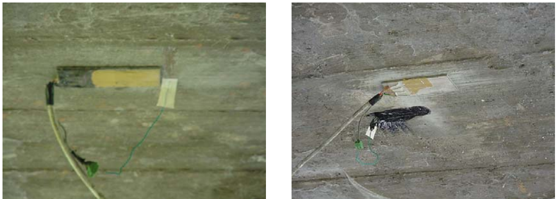
รูปที่ 8-12 ตัวอย่างการติดตั้งอุปกรณ์ตรวจวัดค่าการยึดหนืดของโครงสร้าง
