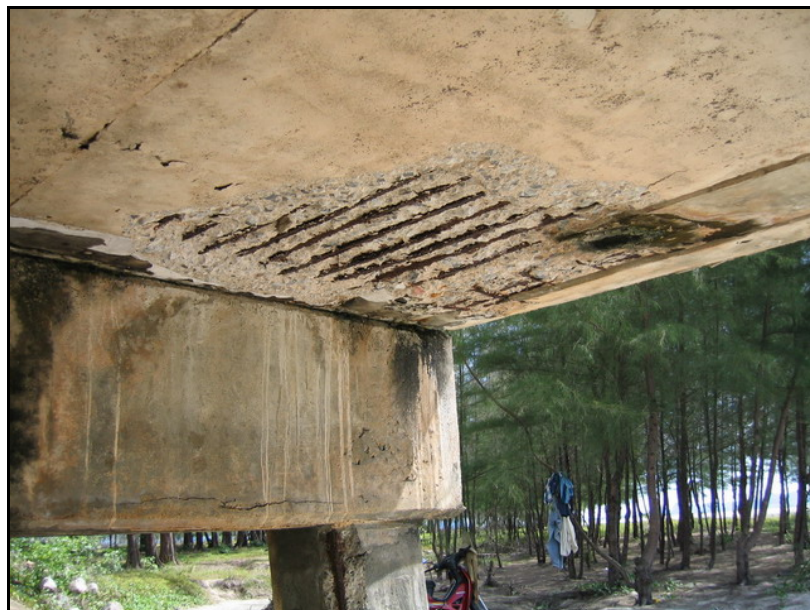
รูปที่ 3-9 Delamination and Spall
