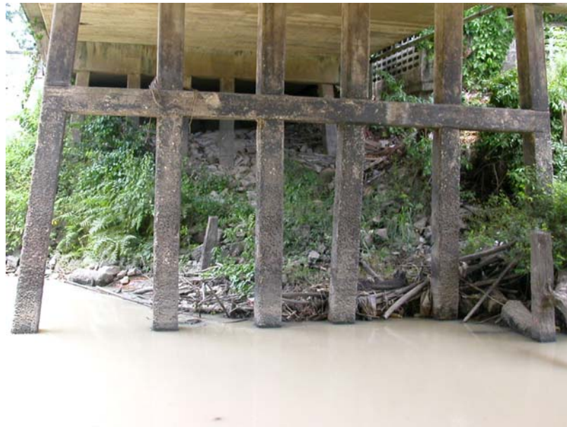
รูปที่ 6-32 การกัดกร่อนและการทับถมของเศษอิฐที่ตอม่อกลางน้ำเหล็ก
