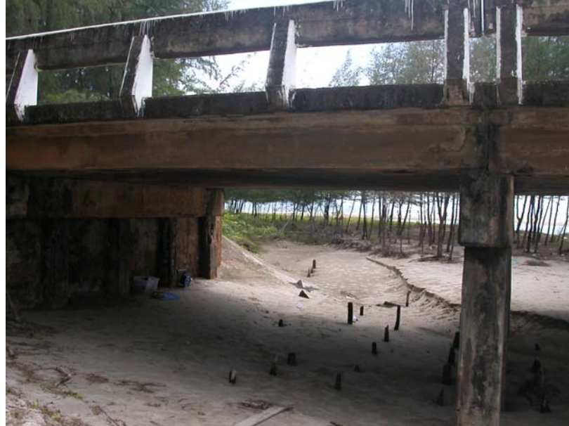
รูปที่ 2-28 Concrete Abutment
