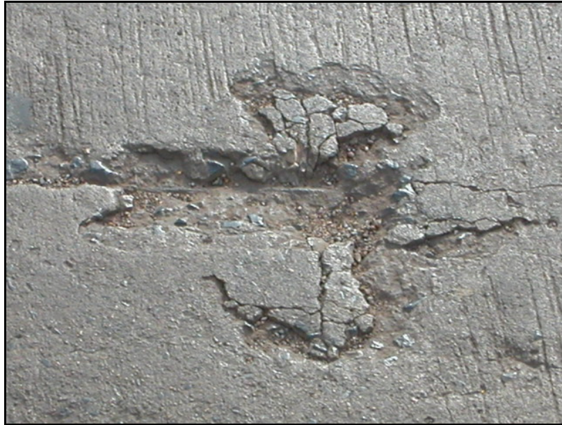
รูปที่ 3-10 Spall (Pothole)
