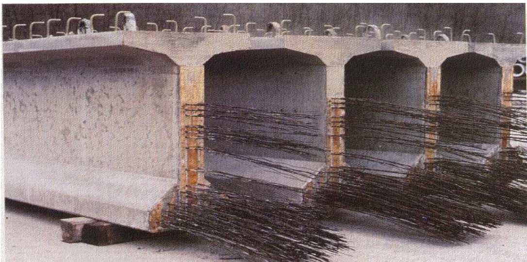
รูปที่ 3-4 ชิ้นส่วนคอนกรีตอัดแรงชนิดดึงก่อน (Pretensioning)
