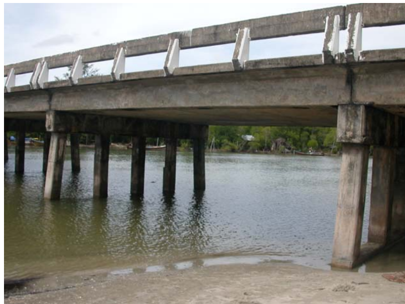
รูปที่ 2-29 Concrete Pier
