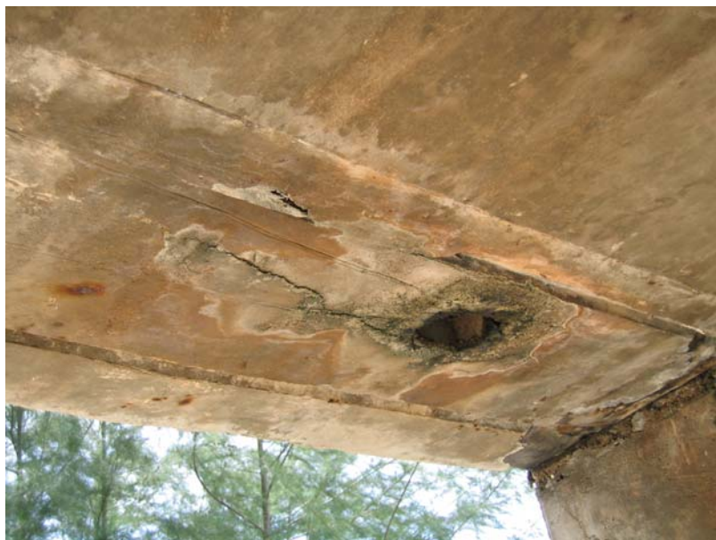
รูปที่ 6-12 Delamination และ Efflorescence ที่มี Rust Stains อยู่ที่ด้านล่างของ Slab
