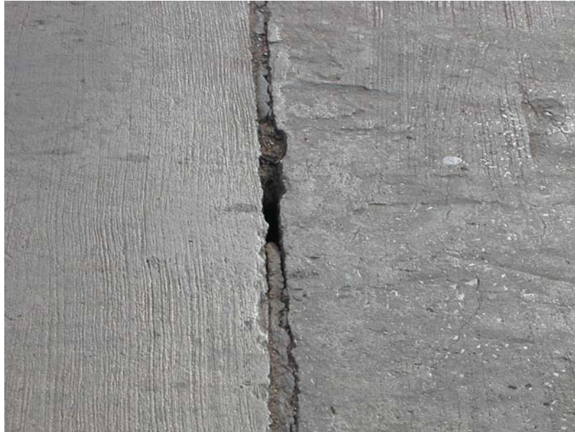
รูปที่ 6-7 ความเสียหายของ Compression Seal
