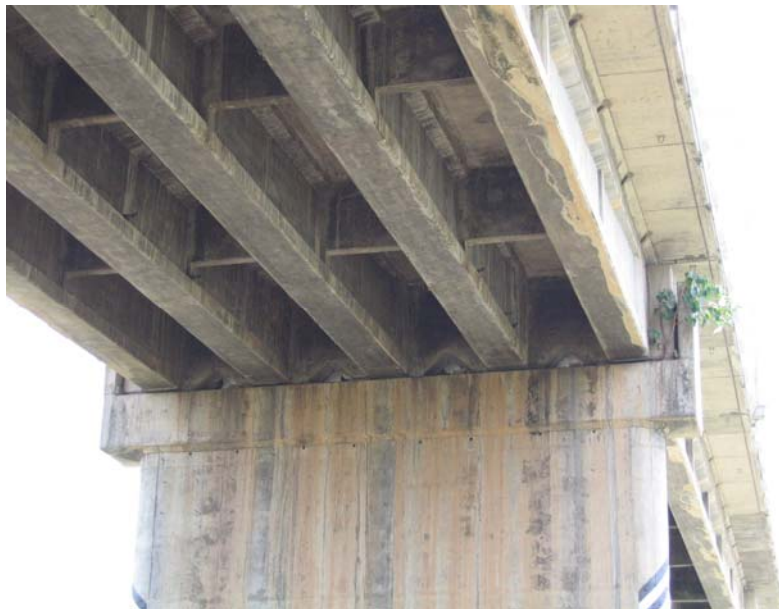
รูปที่ 6-18 สะพานแบบ Prestressed I-Beam
