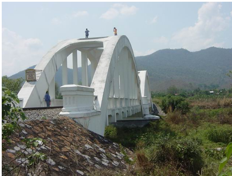
รูปที่ 2-26 สะพานคอนกรีตรูปโค้ง
