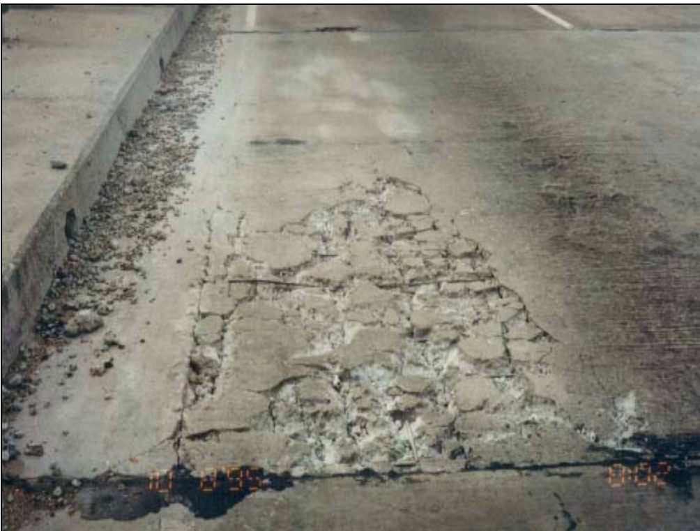
รูปที่ 3-2 การเสียหายอย่างรุนแรงที่ด้านบนของพื้นสะพาน
