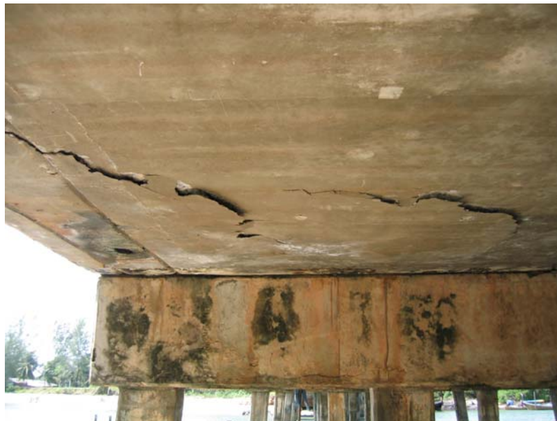
รูปที่ 2-3 การหลุดแยกออกเป็นแผ่นๆ ใต้พื้นสะพาน
