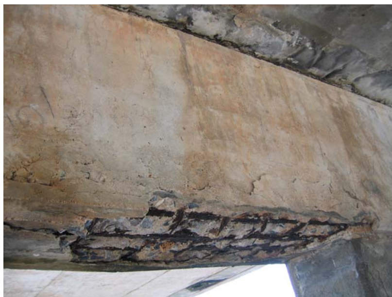
รูปที่ 2-4 การหลุดแยกออกเป็นแผ่นๆ ใต้คานขวางบนตอม่อสะพาน
