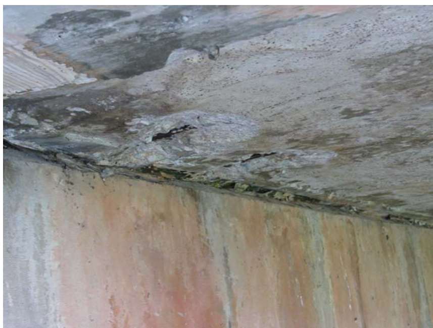
รูปที่ 2-5 การหลุดร่อนได้ผ่านพื้นสะพาน
