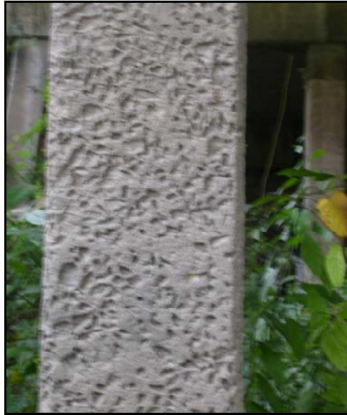
รูปที่ 2-9 การสึกกร่อนของเสาตอม่อ
