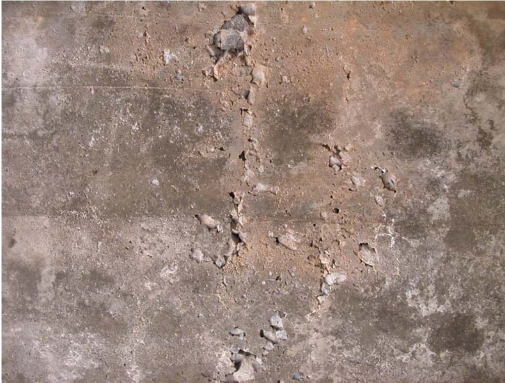
รูปที่ 3-3 คอนกรีตอิ่มตัวด้วยน้ำ (Water Saturated Concrete)
