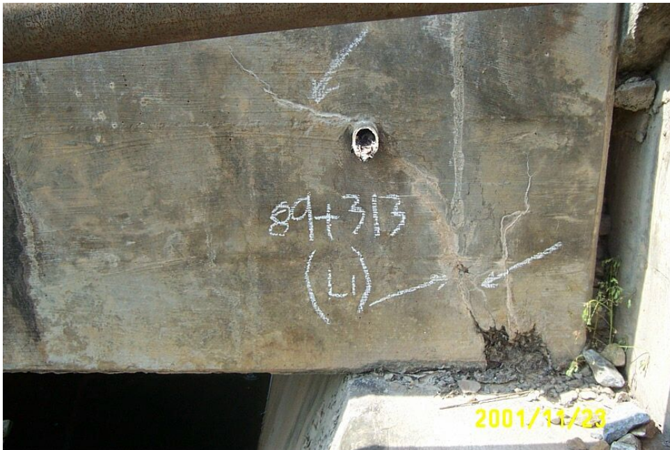
รูปที่ 2-2 รอยแตกเนื่องจากแรงเฉือนบริเวณใกล้แผ่นรองสะพาน
