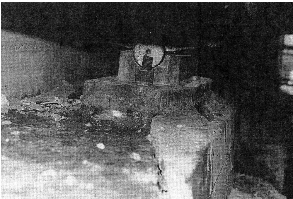
รูปที่ 8-3 ความเสียหายของคอนกรีตที่สลักเกลียว Bearing
