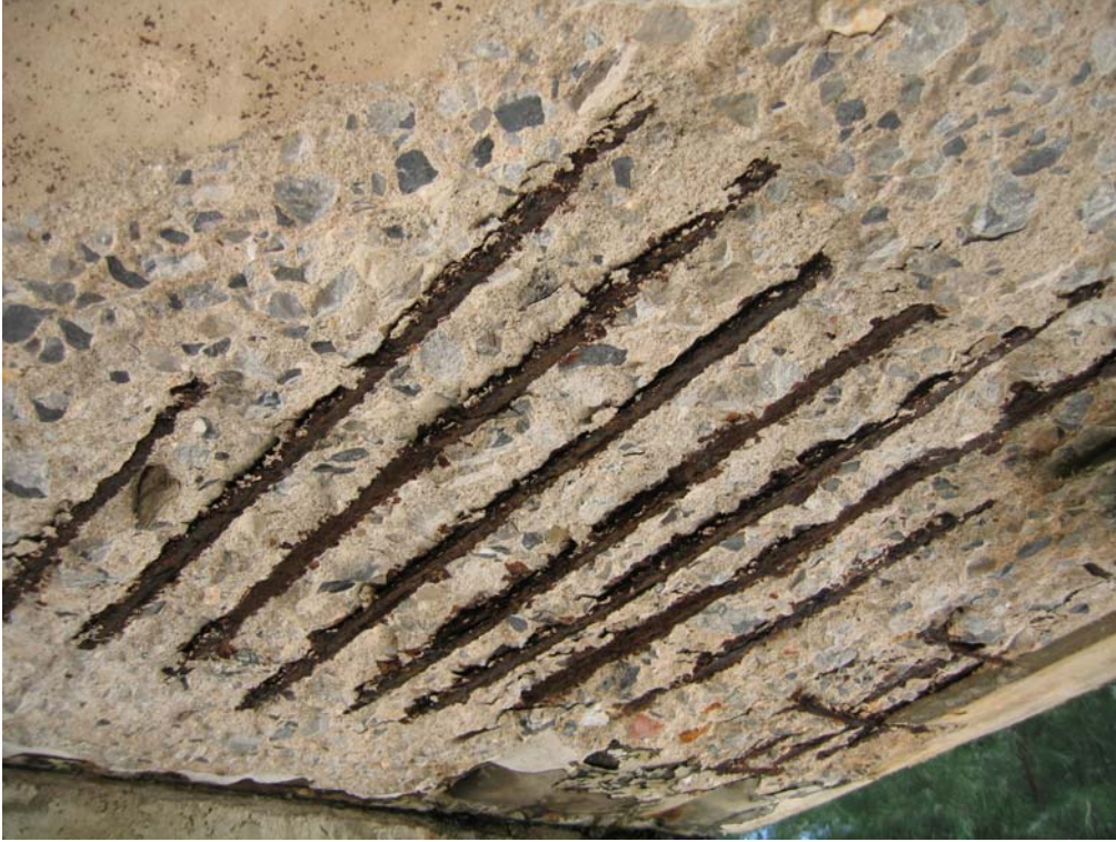
รูปที่ 3-1 การเสียหายอย่างรุนแรงที่ด้านล่างของพื้นสะพาน
