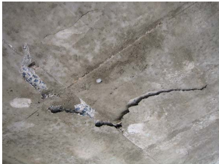
รูป 5-2 การหลุดร่อนของผิวคอนกรีต
