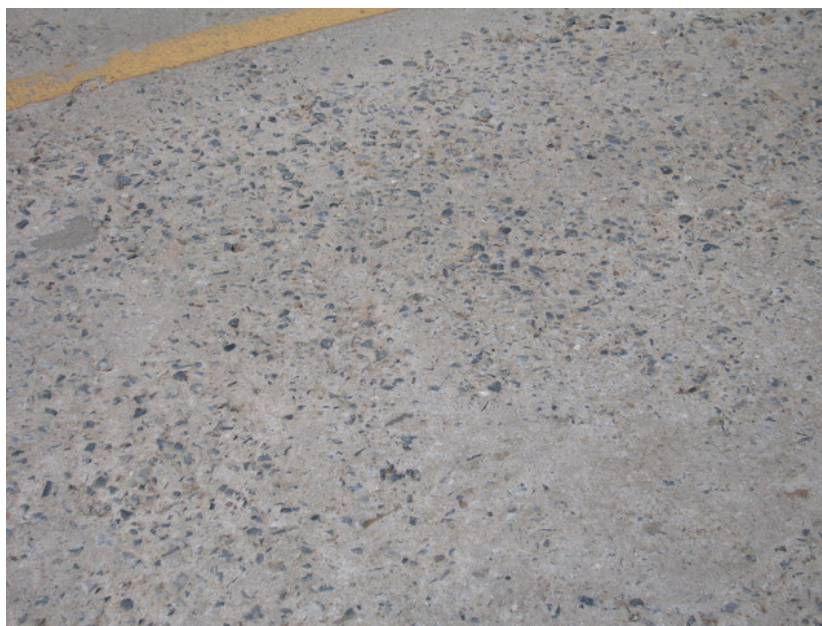
รูปที่ 2-8 การสึกกร่อนของผิวคอนกรีต
