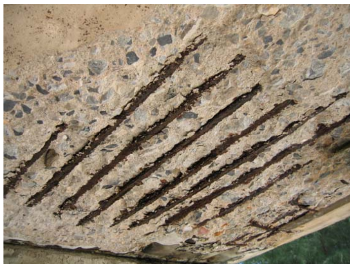
รูป 5-3 การเกิดสนิมในเหล็กเสริม
