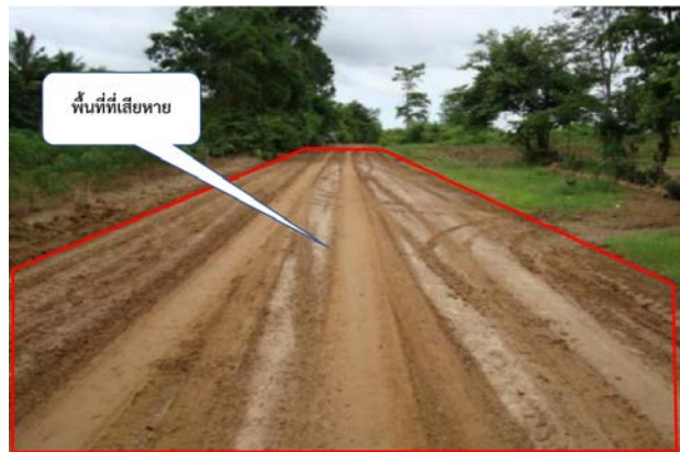
รูปที่ 1 ตัวอย่างการประเมินพื้นที่ที่เกิดความเสียหายของผิวทางลูกรัง
