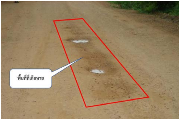
รูปที่ 1 ตัวอย่างการประเมินพื้นที่ที่เกิดความเสียหายของผิวทางลูกรัง
