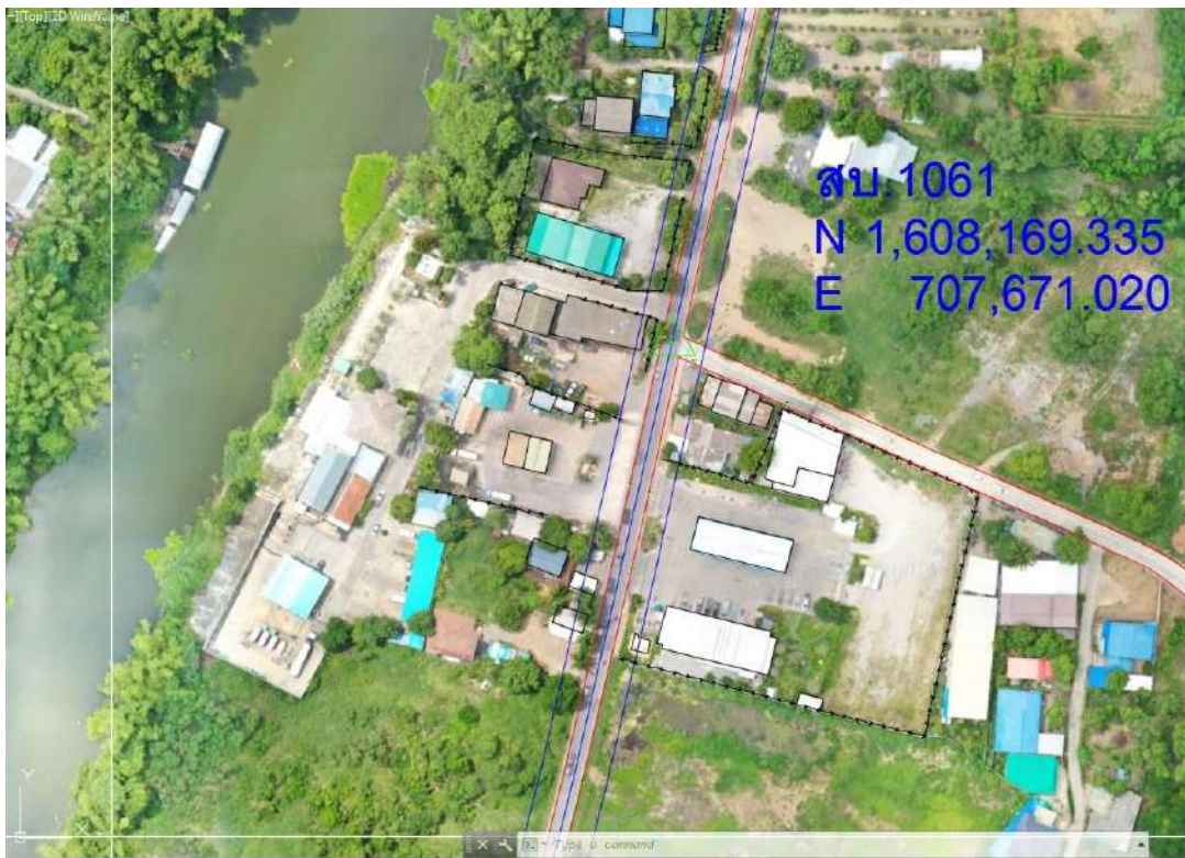
รูปที่ 6-3 ตัวอย่างงานปักแนวถนนโครงการคมนาคมสาย ค10 จังหวัดสระบุรี
