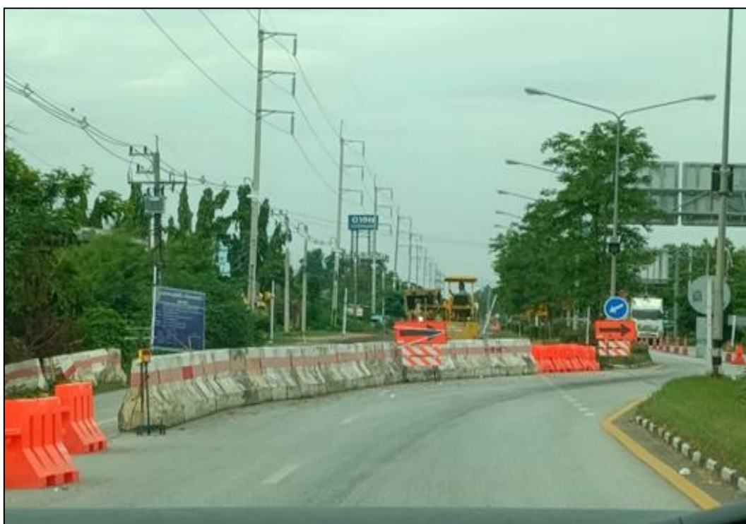
รูปที่ 4-8 พบการก่อสร้างถนนในระหว่างสำรวจ
