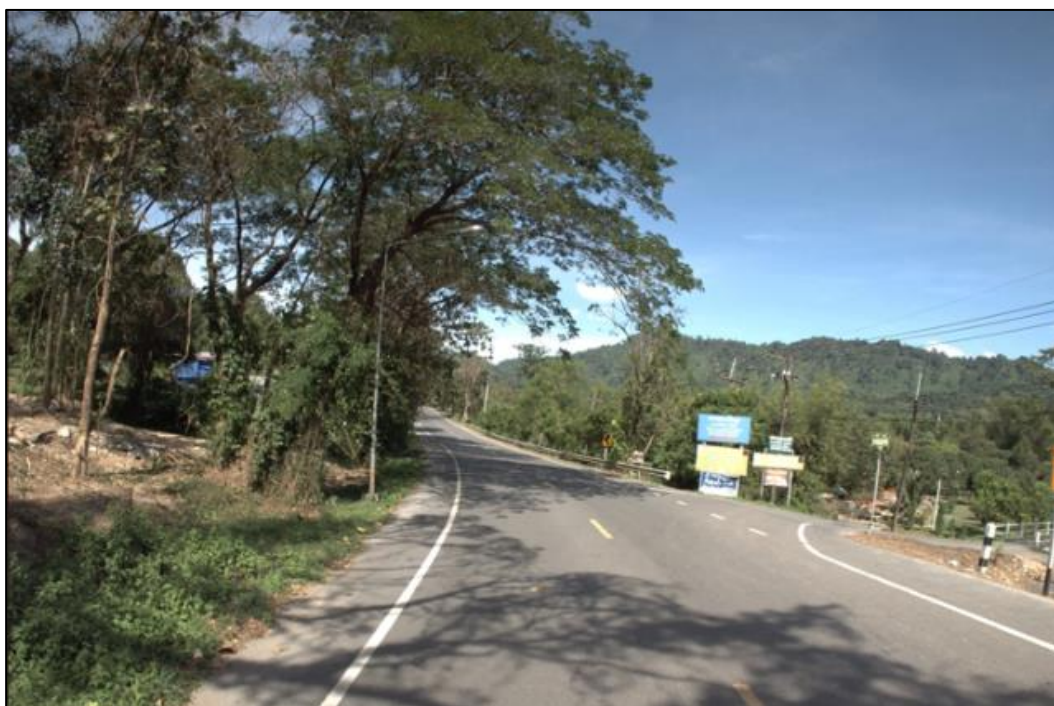
รูปที่ 3-41 พื้นที่ทดสอบที่ 4 ทางหลวงหมายเลข 3050 ตอน 100
