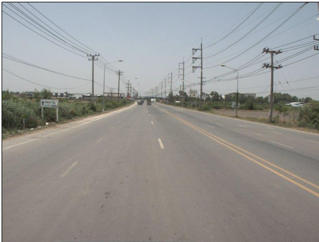
รูปที่ 3-40 พื้นที่ทดสอบที่ 3 ทางหลวงหมายเลข 3312 ตอน 200
