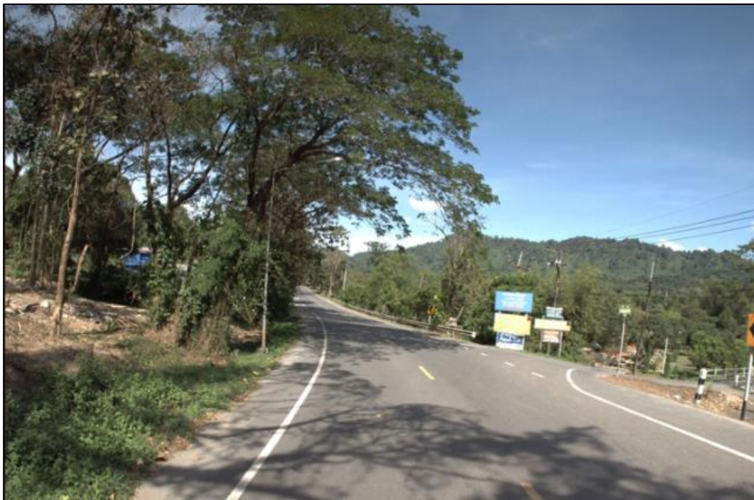
รูปที่ 2-41 พื้นที่ทดสอบที่ 4 ทางหลวงหมายเลข 3050 ตอน 100
