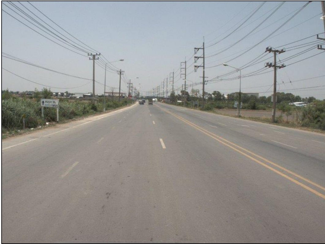
รูปที่ 2-40 พื้นที่ทดสอบที่ 3 ทางหลวงหมายเลข 3312 ตอน 200
