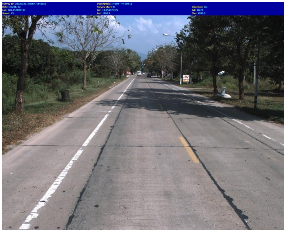
รูปที่ 22 ภาพถนนคอนกรีต Section 3 และ Section 4
