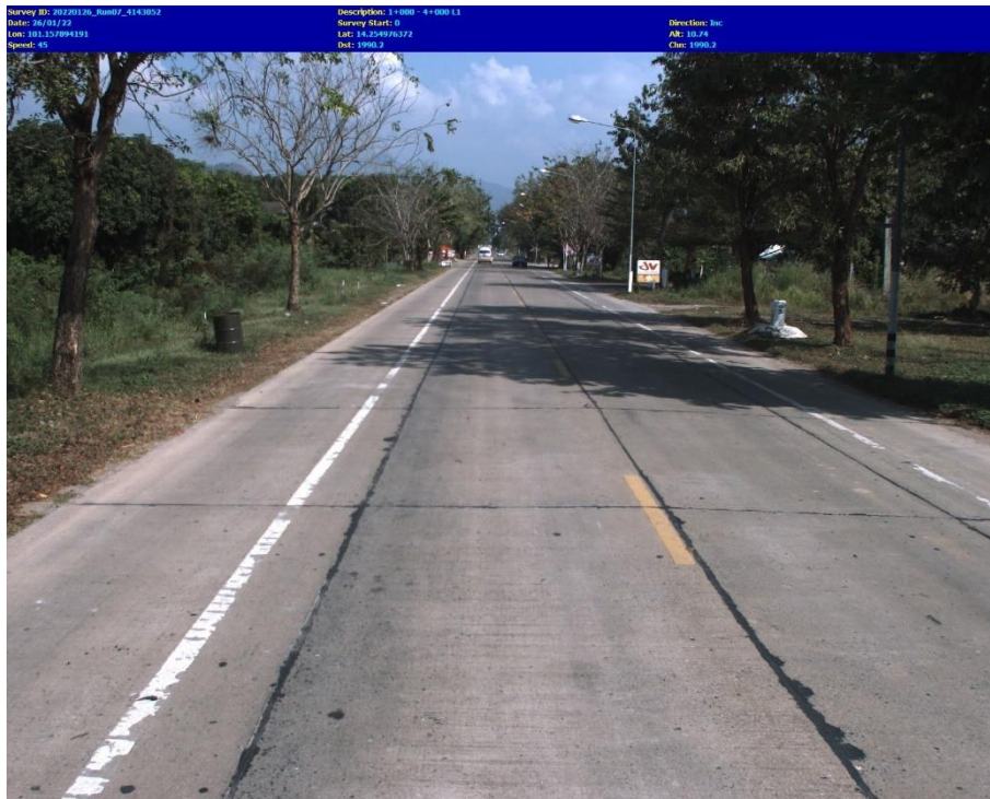
รูปที่ 4-55 ภาพถนนคอนกรีต Section 3 และ Section 4
