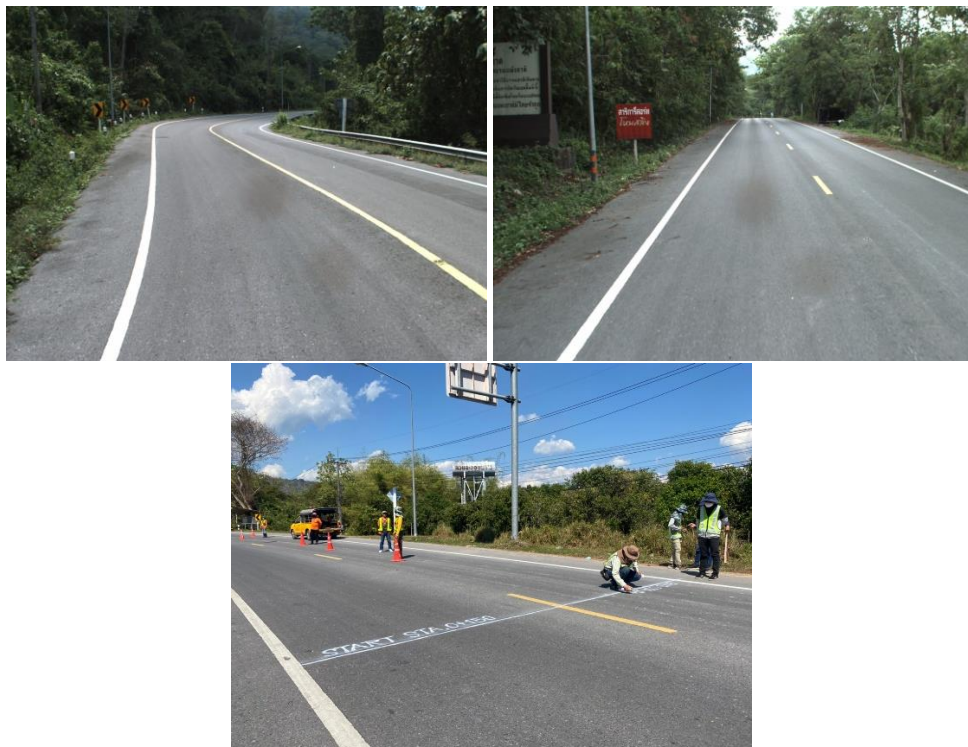
รูปที่ 4-42 พื้นที่ทดสอบอุปกรณ์ ทางหลวงหมายเลข 3050 ตอน 100 ผิวทางลาดยาง มีพื้นที่ทางโค้งและทางลาดชัน
