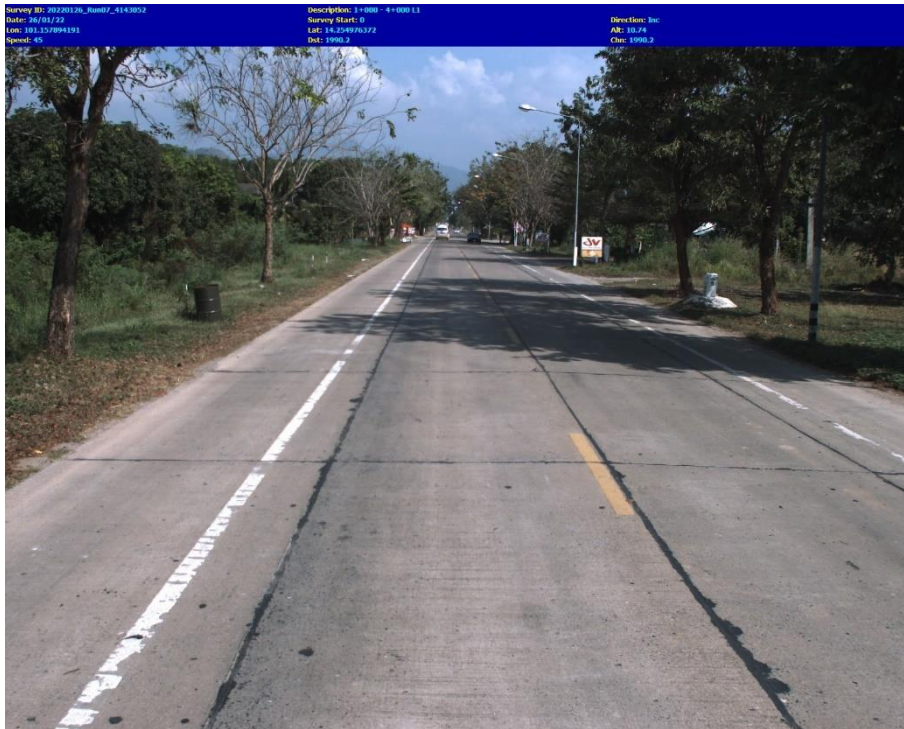
รูปที่ 3-55 ภาพถนนคอนกรีต Section 3 และ Section 4
