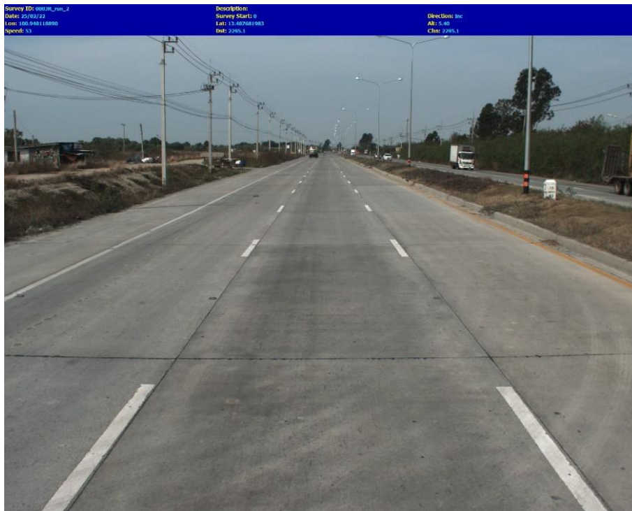
รูปที่ 3-57 ลักษณะผิวทางคอนกรีต ทางหลวงหมายเลข 3 ตอน 200 กม. 70+500 ถึง กม. 72+500
