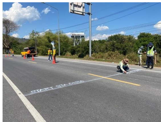
รูปที่ 3-42 พื้นที่ทดสอบอุปกรณ์ ทางหลวงหมายเลข 3050 ตอน 100 กิโลเมตรทางลาดยาง มีพื้นที่ทางโค้งและทางลาดชัน
