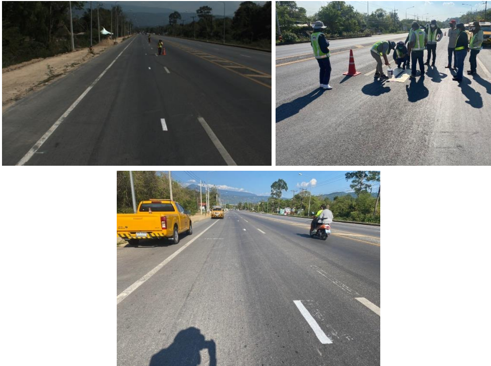
รูปที่ 3-45 พื้นที่ทดสอบอุปกรณ์ ทางหลวงหมายเลข 3049 ตอน 100 ผิวทางลาดยาง มีการกำหนดเส้นเล็งแนว เพื่อให้รถสำรวจที่ทำการทดสอบ วิ่งไปในแนวเดียวกัน
