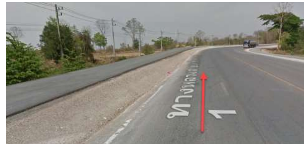
รูปที่ 8 ทิศทางการสำรวจกรณีที่ไม่สามารถทำการสำรวจในช่องจราจรด้านซ้ายสุดของถนนได้
