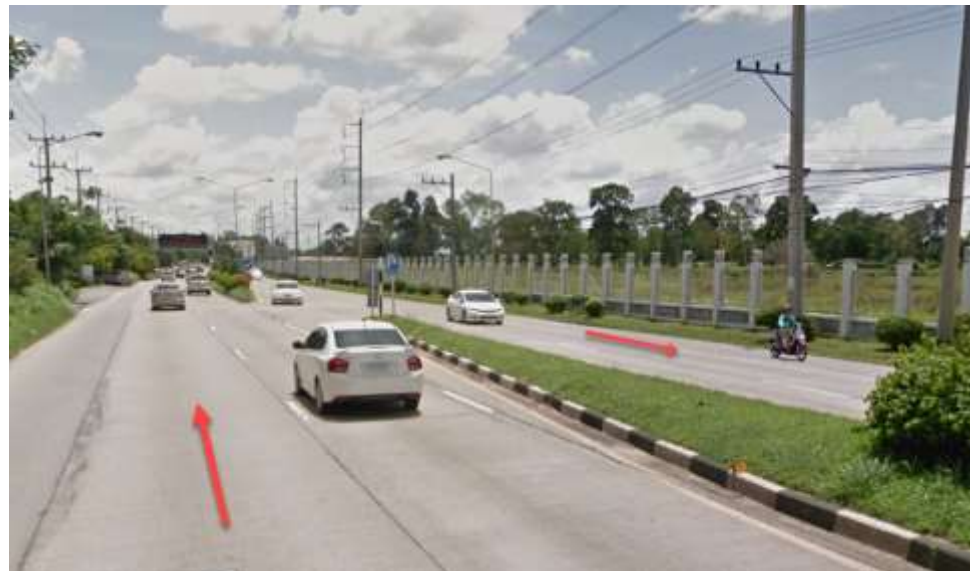
รูปที่ 6 ทิศทางการสำรวจช่องจราจรด้านซ้ายสุดของถนนทั้ง 2 ทิศทาง
