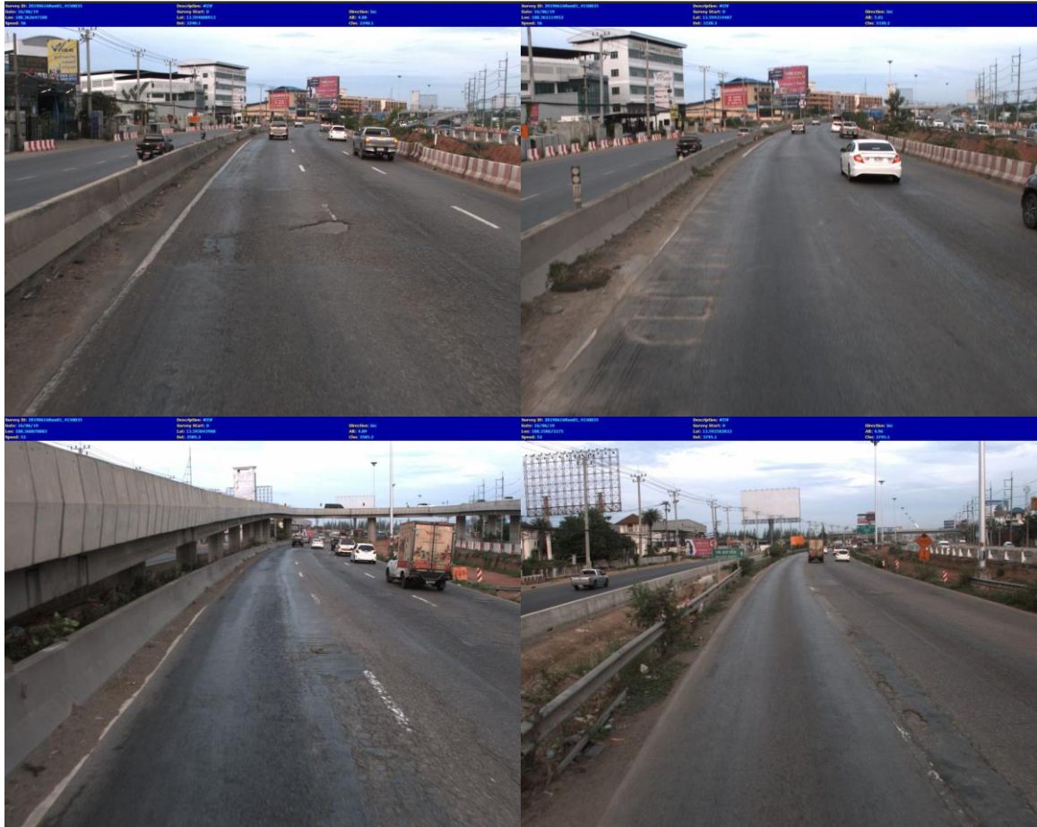
รูปที่ 21 ข้อมูลการสำรวจค่าความเสียหาย จากระบบสารสนเทศโครงข่ายทางหลวง (Roadnet) (สายทาง 35 ตอนควบคุม 201 แสมดำ - สะพานข้ามแม่น้ำท่าจีนฝั่งตะวันตก ระยะทาง 14+660 - 30+275 งบประมาณประจำปี พ.ศ. 2562)
