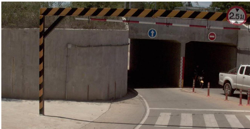
รูปที่ 2-5 ปัญหาไม่สามารถเข้าพื้นที่สำรวจได้ของหมายเลขทางหลวง 2233 ตอนควบคุม 100 ในแขวงทางหลวงขอนแก่นที่ 3 ในวันที่ 11 มิถุนายน พ.ศ.2563 เนื่องจากทางเข้าอุโมงค์มีขนาดเล็กไม่สามารถเข้าสำรวจได้
