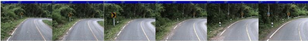
รูปที่ 1-25 เปรียบเทียบค่าความเสียหายที่ STA 3+725 – 3+750
