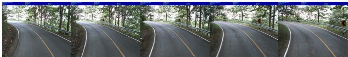
รูปที่ 1-23 เปรียบเทียบค่าความเสียหายที่ STA 2+025 – 2+050
