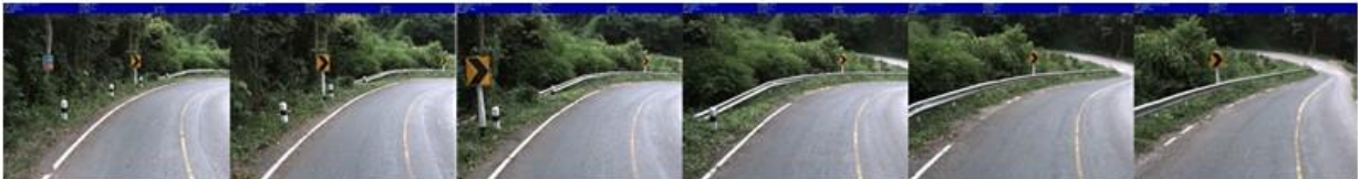
รูปที่ 1-26 เปรียบเทียบค่าความเสียหายที่ STA 3+750 – 3+775
