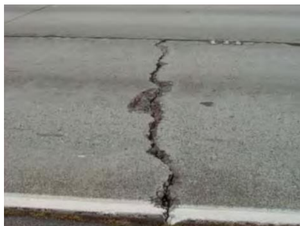
รูปที่ 3-18 รอยบิ่นกระเทาะที่รอยต่อ
