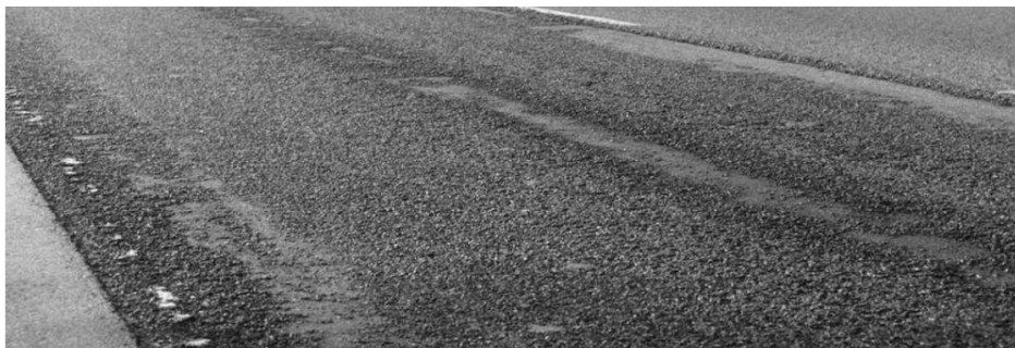
รูปที่ 3-13 การหลุดร่อน
