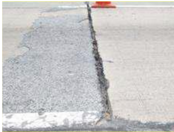
รูปที่ 3-21 ความเสียหายของวัสดุยาแนวรอยต่อ
