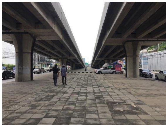
สะพานข้ามแยกศูนย์ราชการ
