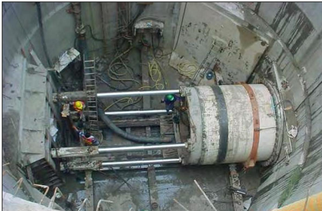
รูปที่ 6.2.1-8 การใช้แม่แรงดันท่อ
