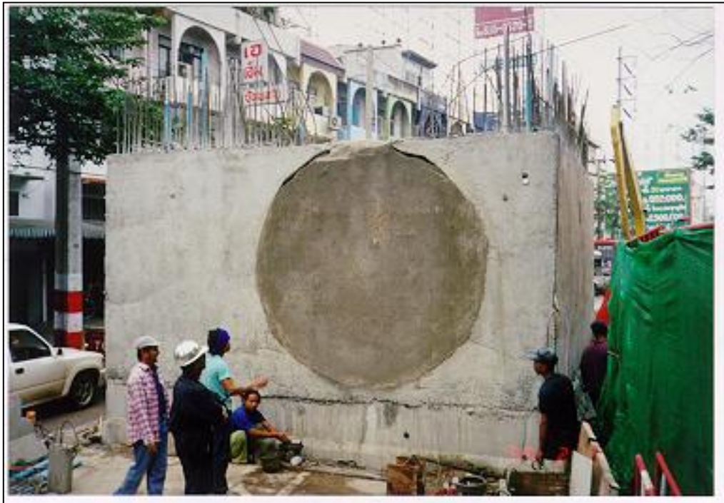
รูปที่ 6.2.1-5 ลักษณะจุดซึ่งหัวเจาะต้องเจาะผ่านออกจากบ่อตันและเข้าบ่อรับ (Soft Eye)
