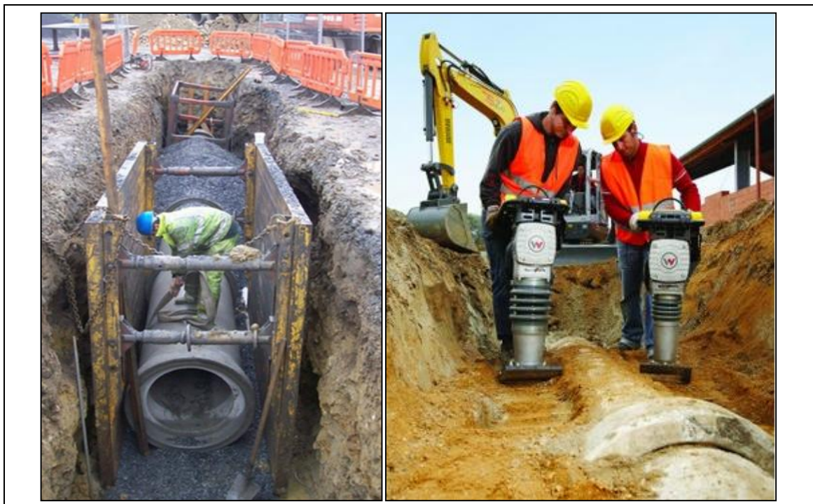
รูปที่ 6.2.1-2 ลักษณะการดำเนินการวางท่อระบายน้ำโดยวิธีขุดเปิดหน้าดิน (Open Cut)
