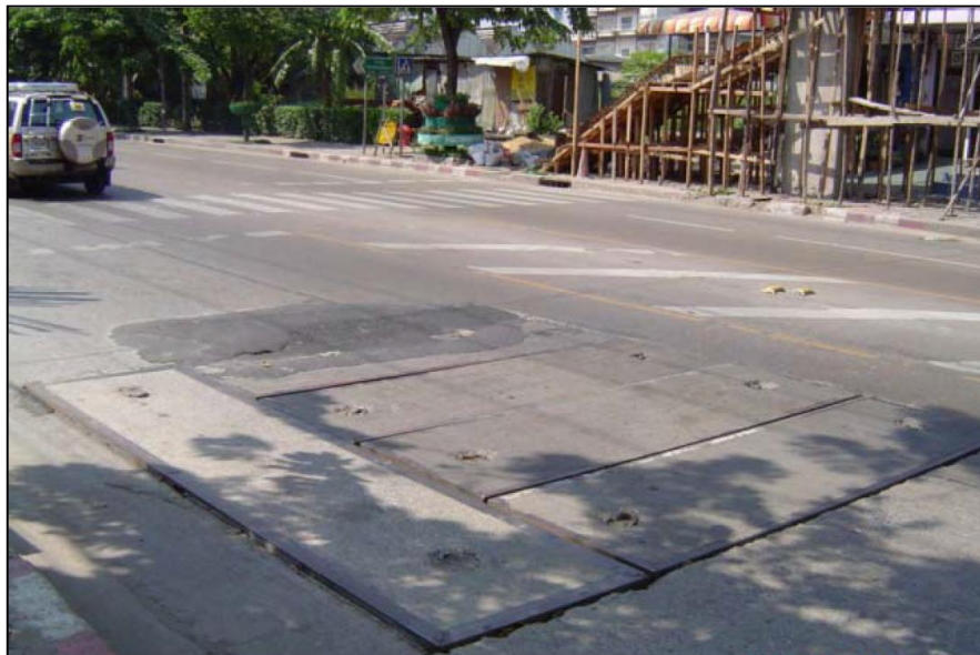
รูปที่ 6.2.1-11 การปิดฝาบ่อด้วยแผ่นคอนกรีต (Concrete Deck)
