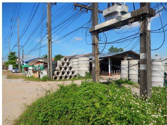
รูปที่ 44 การบุกรุกที่ดินนอกเขตทาง โดยชาวบ้านหลายหลังคาเรือน พื้นที่แขวงทางหลวงเชียงรายที่ 1
