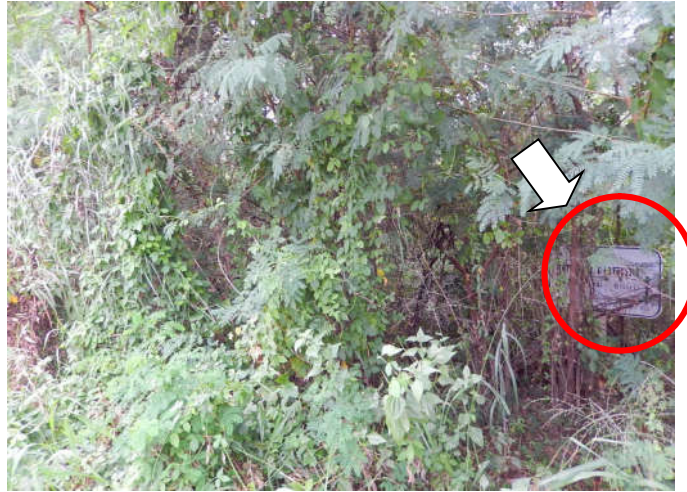
รูปที่ 40 ปัญหาป้ายที่ดินสงวนนอกเขตทางมีหญ้าปกคลุมรกทึบ
