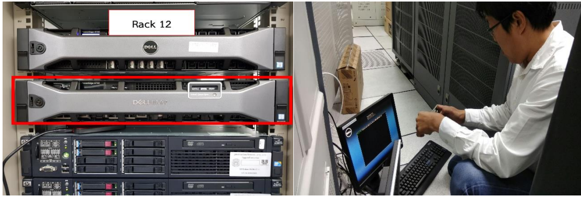
รูปที่ 3-54 ติดตั้งคอมพิวเตอร์แม่ข่าย
