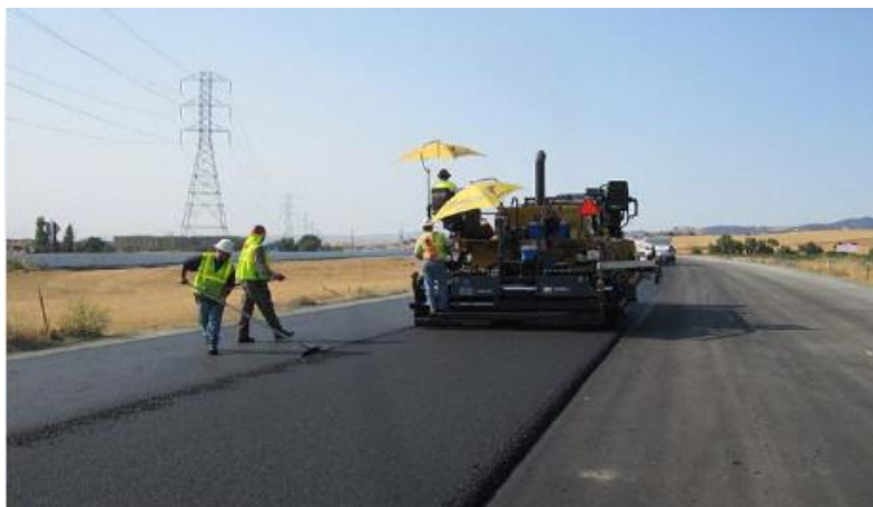
รูปที่ 3-17 งานเสริมผิวลาดยางแอสฟัลต์ติกคอนกรีต
