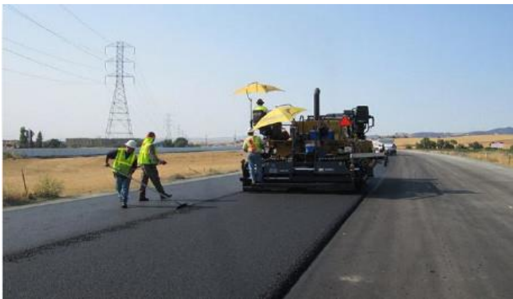
รูปที่ 3-15 งานเสริมผิวลาดยางแอสฟัลต์ติกคอนกรีต
