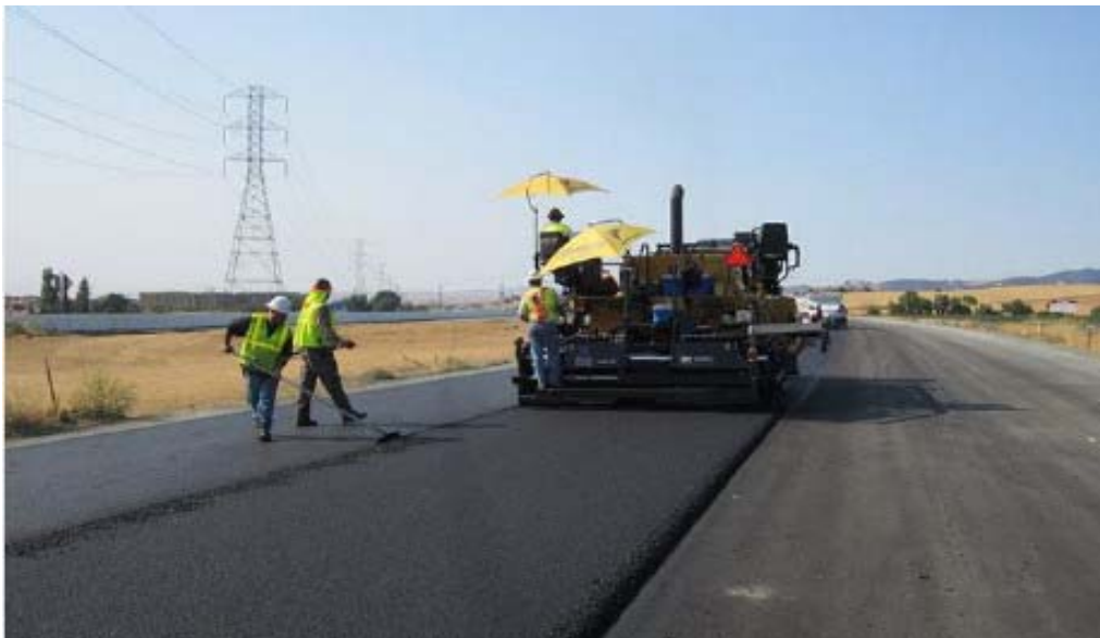
รูปที่ 3-13 งานเสริมผิวลาดยางแอสฟัลต์ติกคอนกรีต
